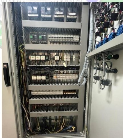
Gambar 2. 9 Panel LVMSB AFL Sumber : Dokumentasi Penulis
