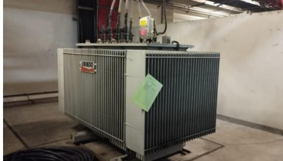
Gambar 2. 5 Trafo Unindo 2000 kVA Sumber : Dokumentasi Penulis
