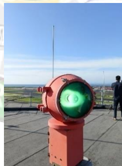
Gambar 2. 33 Rotating Beacon Sumber : Dokumentasi Penulis
