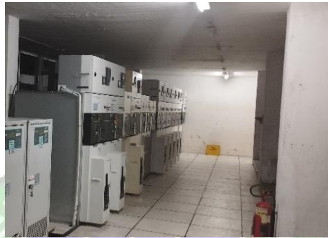
Gambar 2. 4 Gambar Panel TM MPH 1 Sumber : Dokumentasi Penulis
