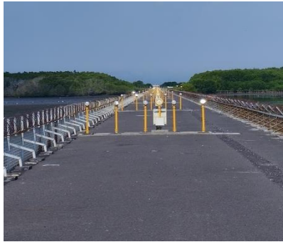
Gambar 2. 19 Gambar Lampu Approach di lapangan Sumber : Dokumentasi Penulis
