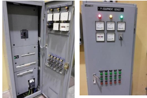
Gambar 2. 10 Panel Equipment Genset Lt.1 MPH 2 Sumber : Dokumentasi Penulis
