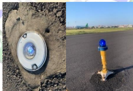
Gambar 2. 27 Lampu Taxiway Inset dan Lampu Taxiway Elevated Sumber : Dokumentasi Penulis
