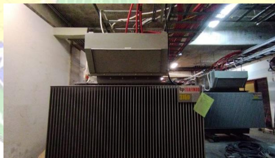
Gambar 2. 7 Trafo Trafindo 3150 kVA
