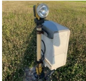
Gambar 2. 32 Lampu RTIL Sumber : Dokumentasi Penulis
