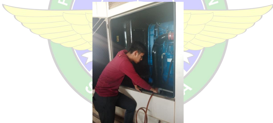
Gambar 4.1 Pengisian Bahan Bakar Secara Manual
