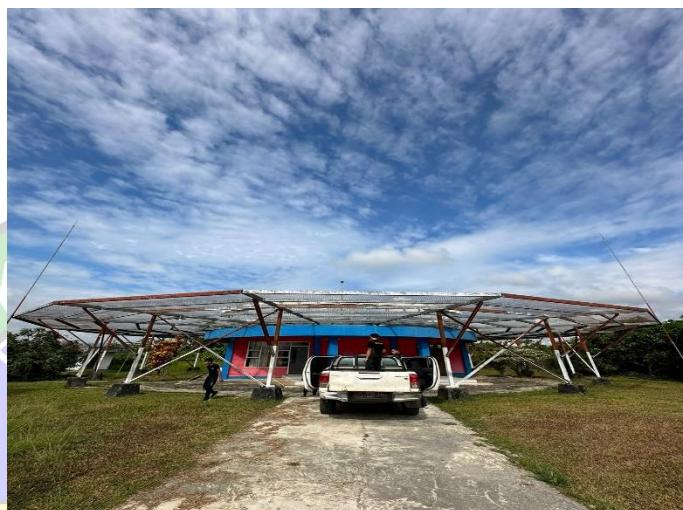
Gambar 3. 13 Antena DVOR di Shelter DVOR
