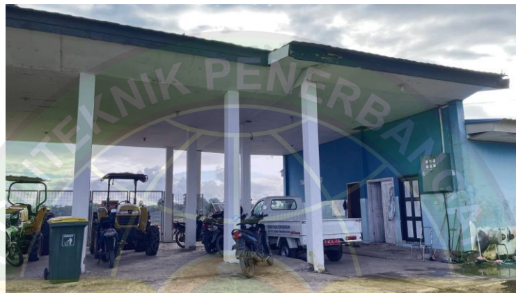
Gambar 4.5 Kantor Unit Bangunan dan Landasan
