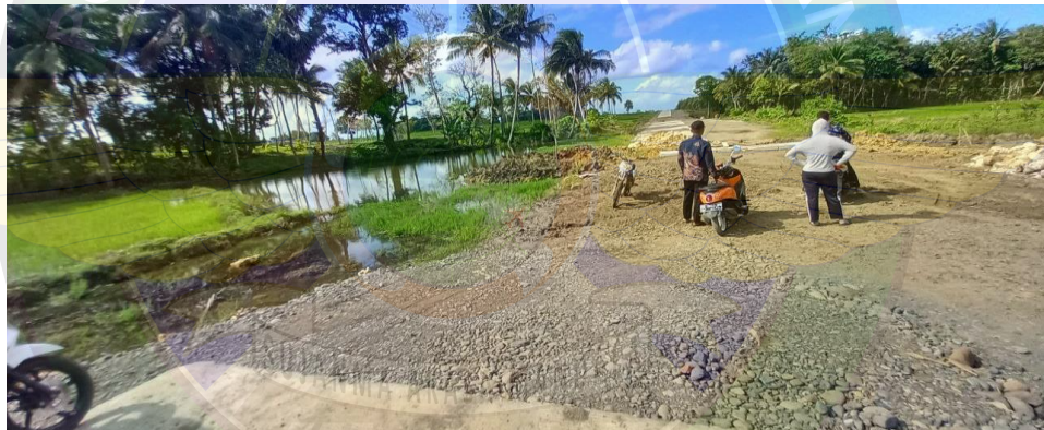
Gambar 4.22 Survey proyek akses jalan bandara
