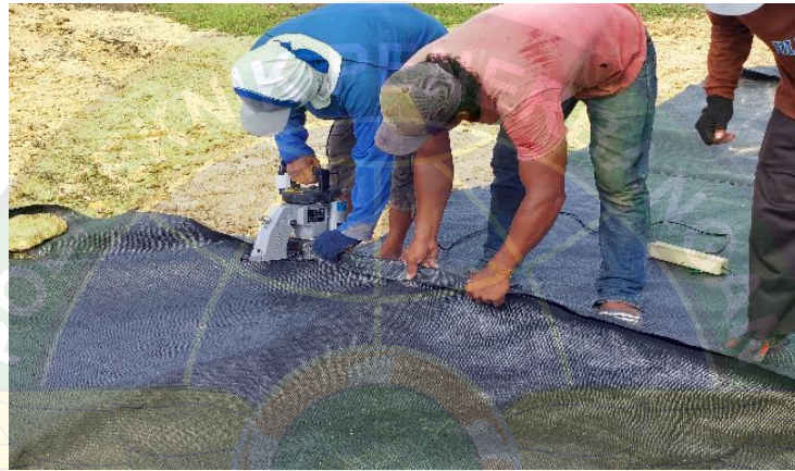
Gambar 4. 19 Penjahitan geotekstil
