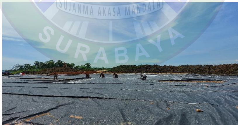
Gambar 4.18 Pemasangan geotekstil
