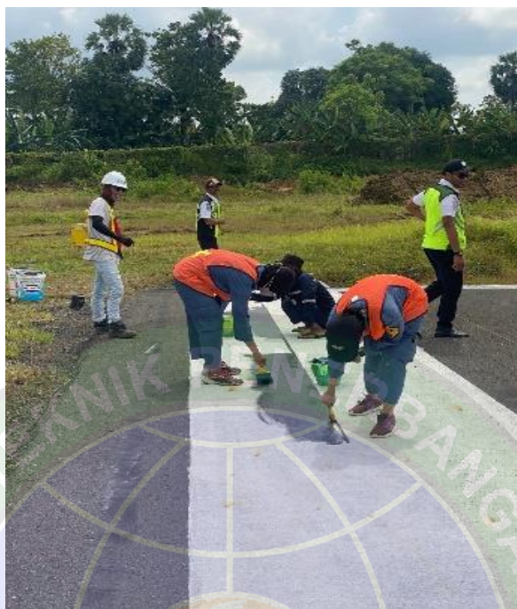
LAMPIRAN 17 : PENGECATAN ULANG TRESHOLD
