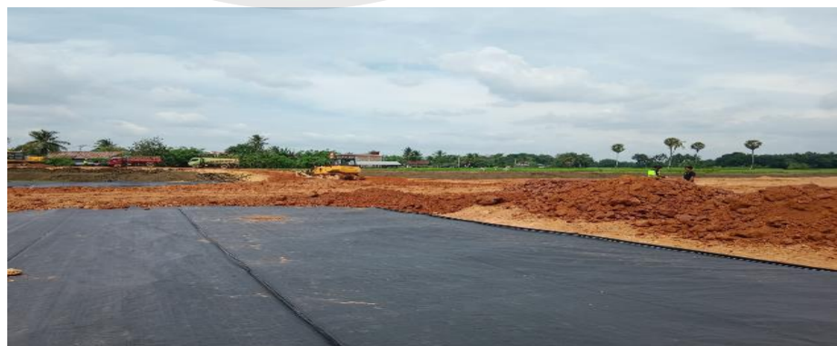
Gambar 4. 21 Penimbunan geotekstil
