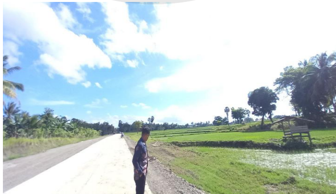
Gambar 4. 31 Bahu jalan setelah diratakan
