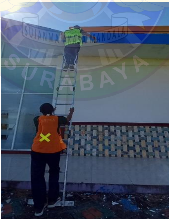
LAMPIRAN 18 : PERAWATAN GEDUNG TERMINAL
