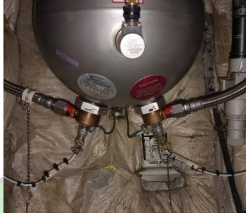
Gambar 4. 10 Connector Telah Diperbaiki
