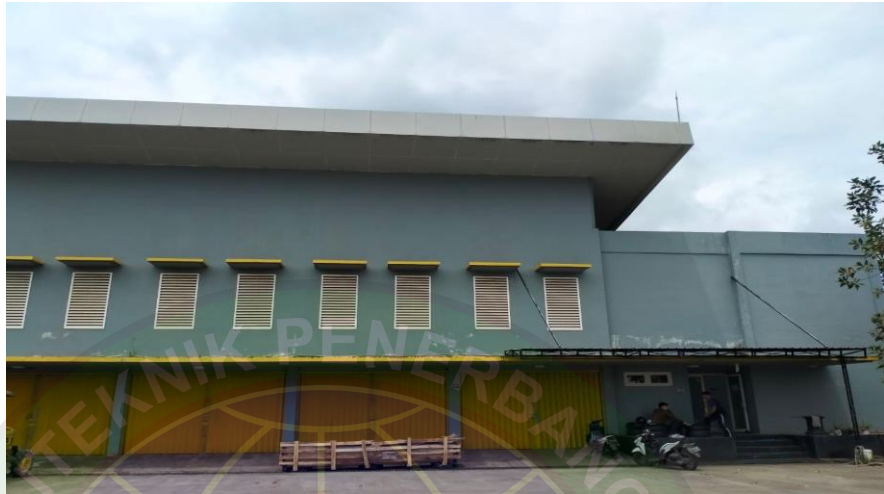
Gambar 4. 4 Gedung Alat-alat berat (Sumber : Dokumentasi Pribadi,2024)
