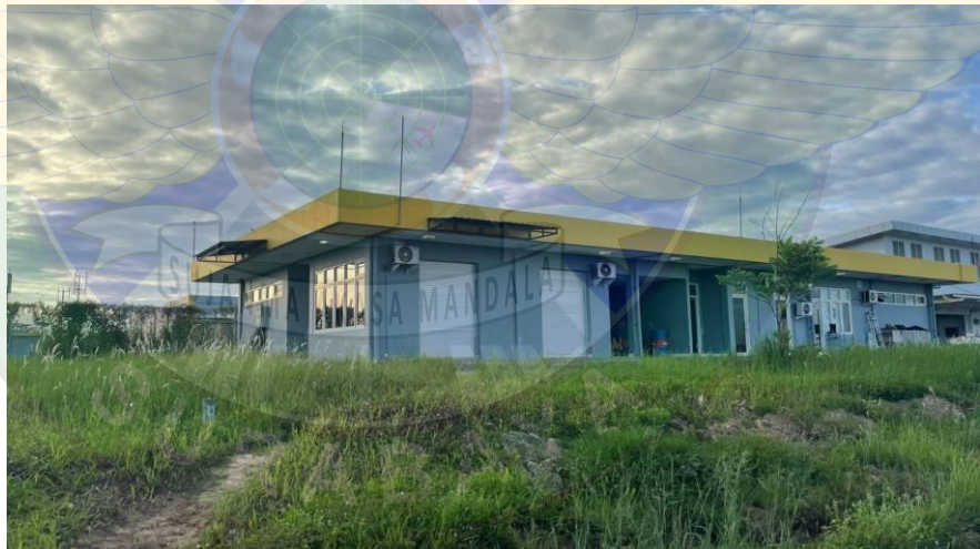
Gambar 4. 9 Chiller (Sumber : Dokumentasi Pribadi, 2024)
