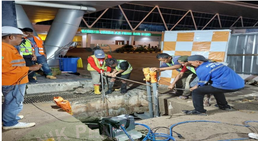
Gambar 4. 33 Pemasangan Bolt Anchor
