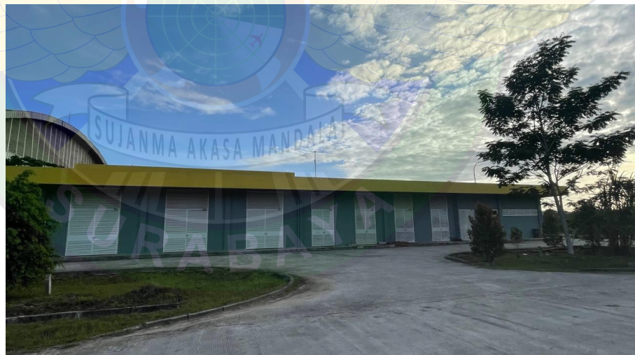
Gambar 4. 5 Gedung Power House (Sumber : Dokumentasi Pribadi, 2024)
