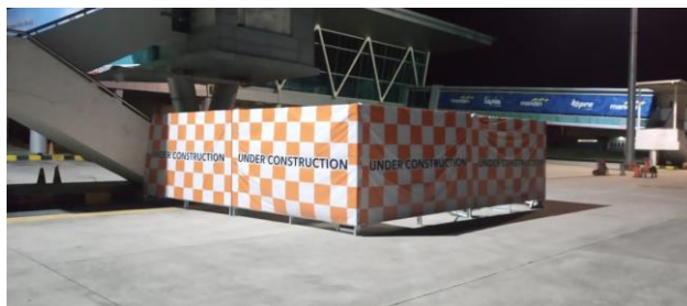
Gambar 4. 26 Pemasangan Pembatas Pekerjaan
