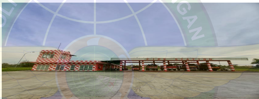
Gambar 4. 11 Gedung PKP-PK (Sumber : Dokumentasi Pribadi, 2024)
