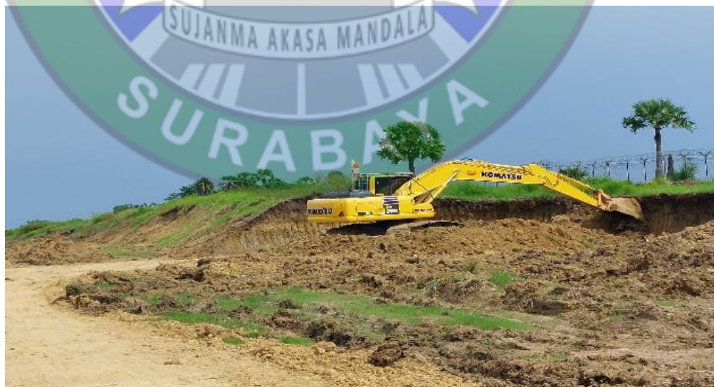
Gambar 4.20. Penggalian Gundukan Area Runway Strip Menggunakan Excavator
