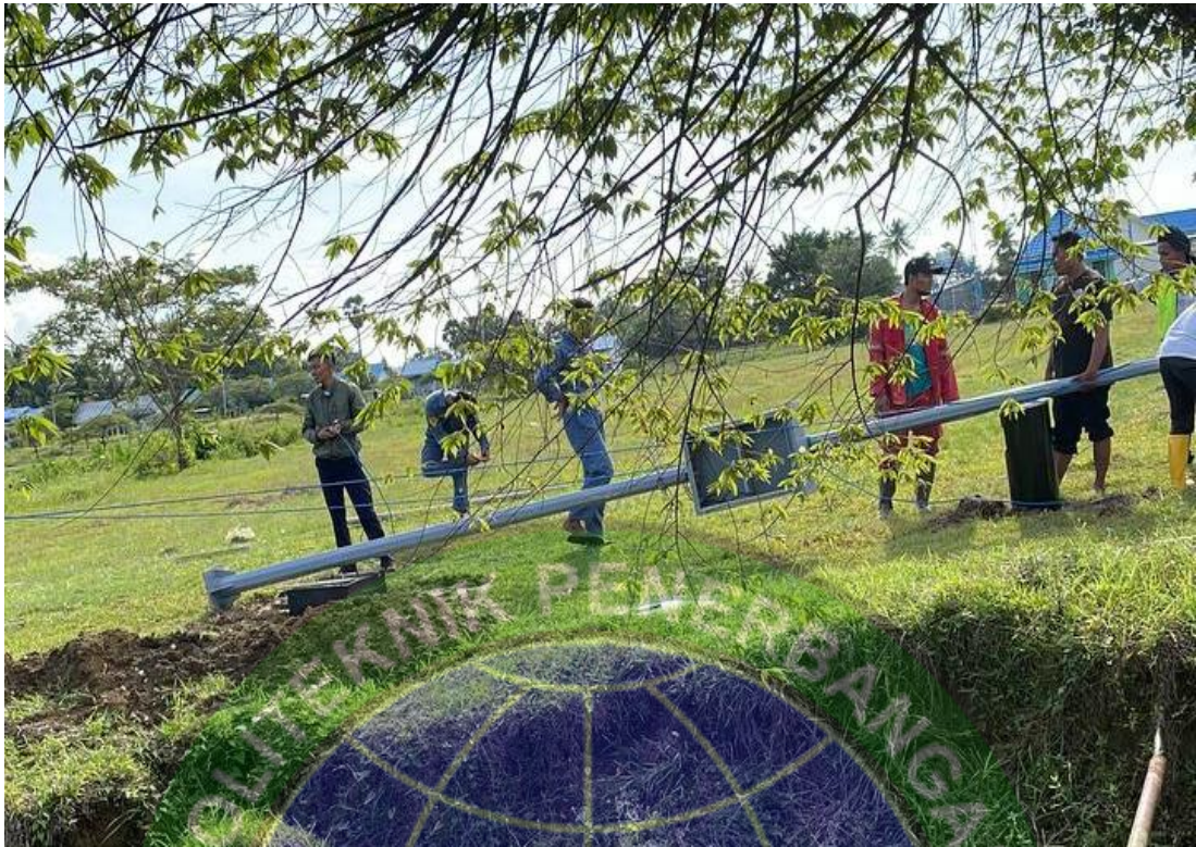
LAMPIRAN 21 : Perbaikan Lampu Jalan
