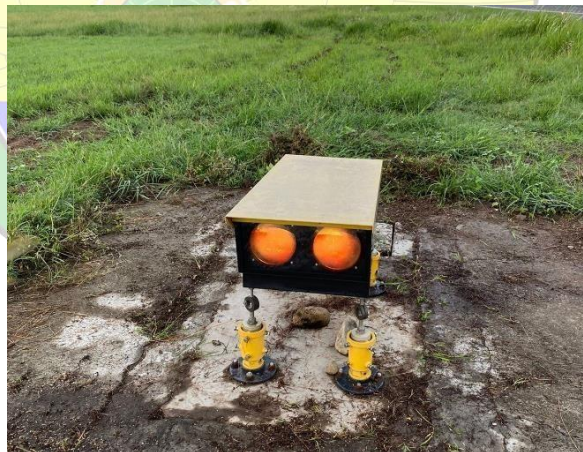
Gambar 2. 8 PAPI ( Precision Approach Path Indicator ) Sumber: Dokumentasi penulis
