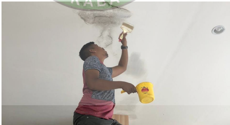
Gambar 4.16 Pengecatan Plafon Gedung Administrasi
