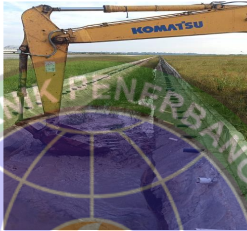
Gambar 4.21 Pembersihan Drainase Sisi Udara (Sumber: Dokumentasi Penulis, Tahun 2024)
