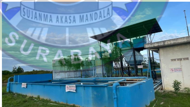
Gambar 4.12 Ground Water Tank (GWT) (Sumber: Dokumentasi Penulis, Tahun 2024)
