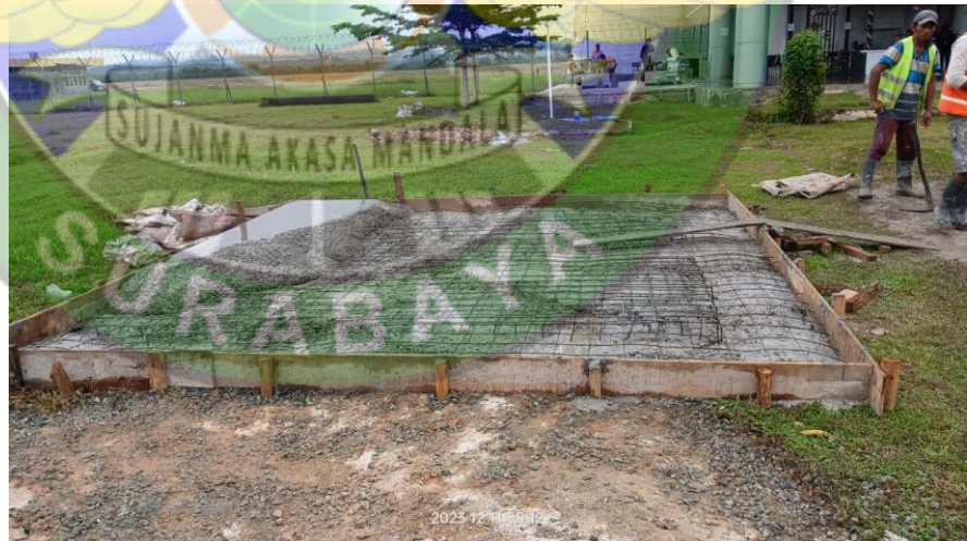
Gambar 4.23 Pemasangan Wiremesh (Sumber: Dokumentasi Penulis, 2024)
