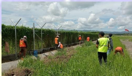
Gambar 4.4 Pemasangan Tiang dan Sekur (Sumber Dokumentasi Penulis)
