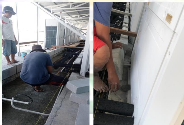
Lampiran 9 pemasangan bata ringan pembatas AC
