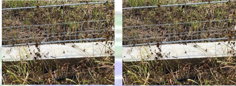
Gambar 4.10 Kondisi Spasi Pagar Setelah Diperbaiki (Sumber Dokumentasi Penulis)
