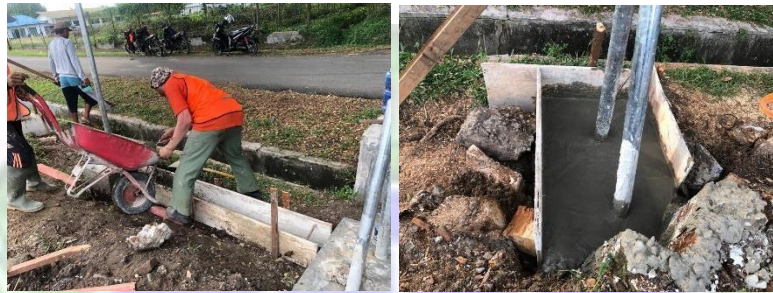
Gambar 4.6 Pengecoran Beton (Sumber Dokumentasi Penulis)
