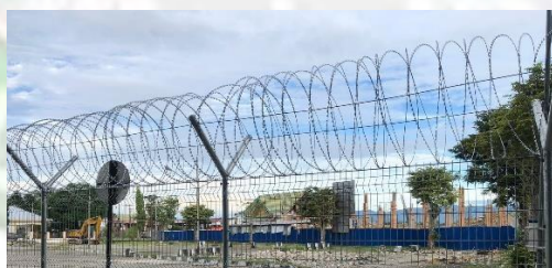
Gambar 4.5 Pemasangan Kawat Silet (Sumber Dokumentasi Penulis)
