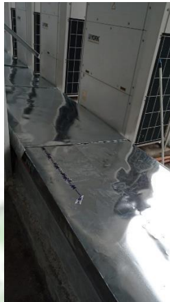
Gambar 4.3 Pemasangan Seng Penutup (Sumber Dokumentasi Penulis)
