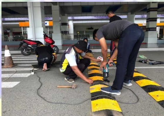
Lampiran 11 Pemasangan Jendulan pada Terminal Penumpang
