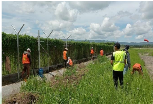
Lampiran 13 Pemasangan Pagar Pengaman Sisi Udara
