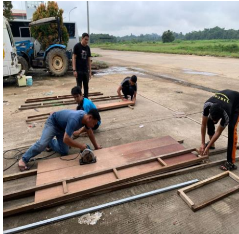
Pembuatan bekisting
