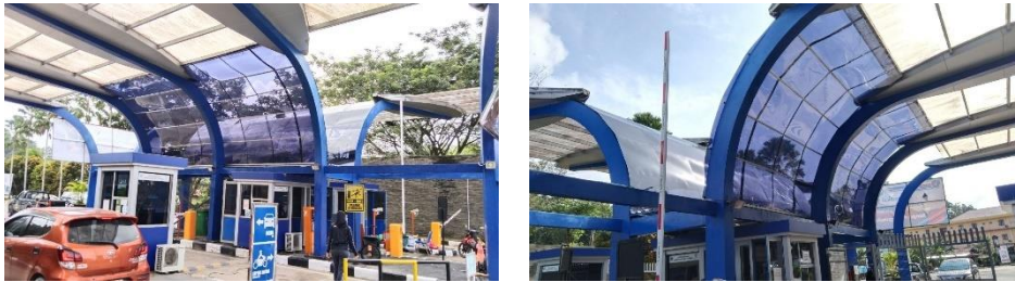
Gambar 4. 29 Hasil pemasangan atap sollar tuff
