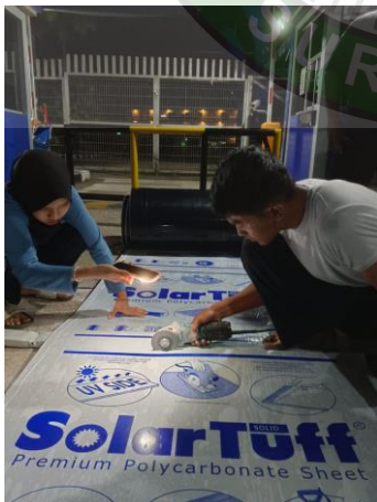
Pemotongan sollar tuff
