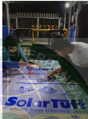
Gambar 4. 27 Pemotongan sollar tuff
