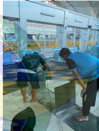
Penggantian keramik terminal keberangkatan
