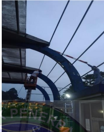
Gambar 4. 25 Pemasangan kerangka atap
