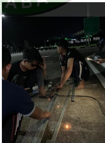
Gambar 4. 24 penyambungan besi hollow
