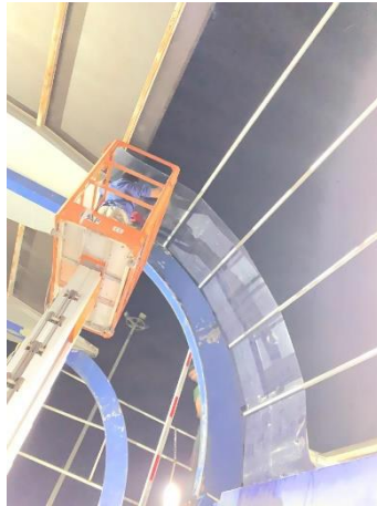
Gambar 4. 28 Pemasangan sollar tuff pada kerangka
