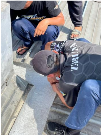
Pemasangan fiber dan resin talang air
