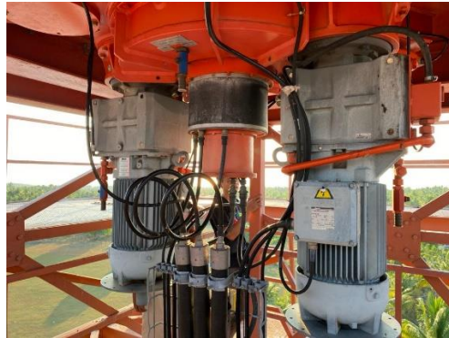
Gambar 3. 22 Soket Antenna, Motor 1 dan Motor 2 Sumber : Dokumentasi Penulis 16 Oktober 2023
