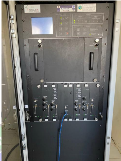
Gambar 3. 13 Kabinet DME Sumber : Dokumentasi Penulis 1 Oktober 2023
