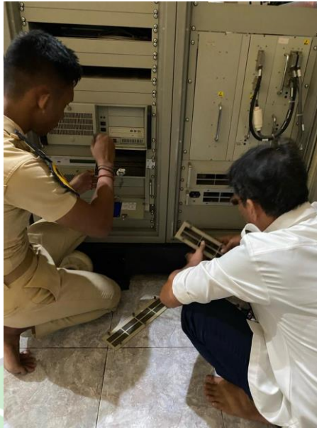
Gambar 3. 20 Pembersihan Fan Sumber : Dokumentasi Penulis 16 Oktober 2023
