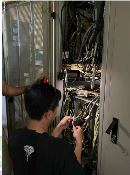
Gambar 3. 27 Pemasangan Kabel MDRP Sumber : Dokumentasi Penulis 16 Oktober 2023
