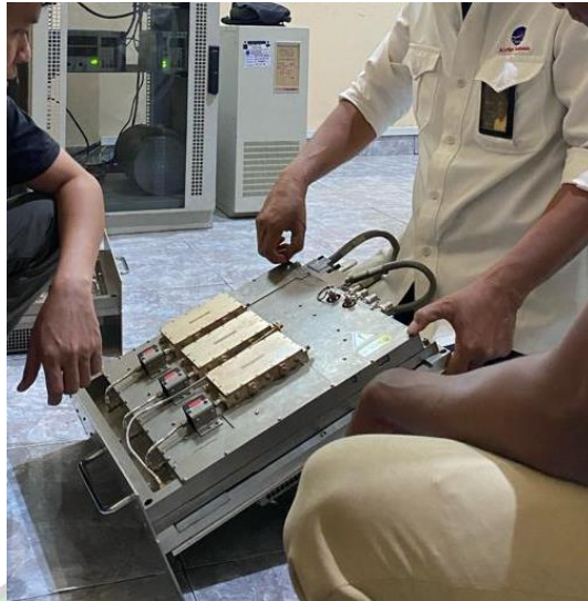
Gambar 3. 25 Pemasangan Bracket MDRP Sumber : Dokumentasi Penulis 16 Oktober 2023
