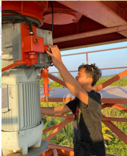
Gambar 3. 21 Pengecekan Level Oil, Soket Antenna, Motor 1 dan Motor 2 Sumber : Dokumentasi Penulis 16 Oktober 2023
