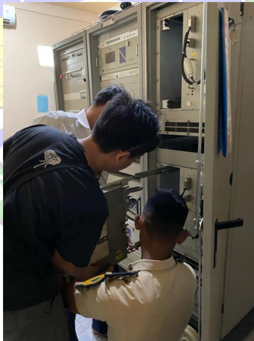
Gambar 3. 26 Pemasangan Modul MDRP Sumber : Dokumentasi Penulis 16 Oktober 2023
