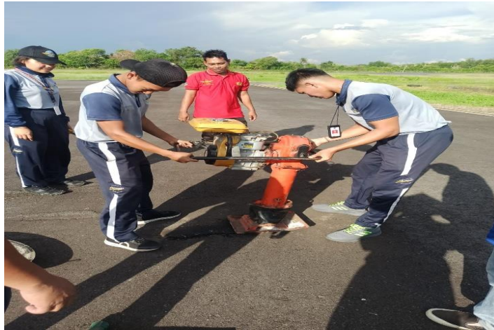
Gambar 4.19 Pemadatan menggunakan combination vibrating rammer
