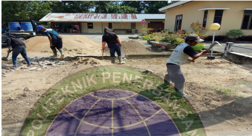
Gambar 4.14 Pemadatan tanah
