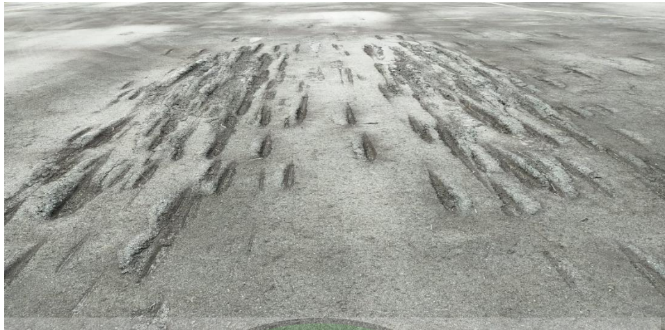
Gambar 4.11 Kerusakan perkerasan pada parking stand 4
