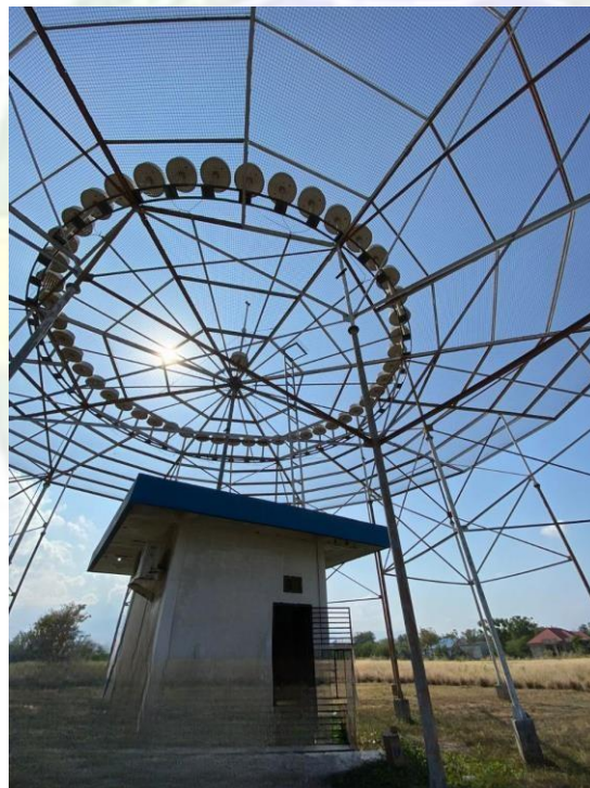
Gambar 3. 11 Antena dan Shelter DVOR
