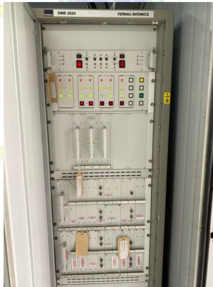
Gambar 3. 17 Peralatan T-DME Sumber: Dokumentasi Penulis (2023)
