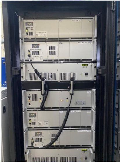
Gambar 3. 12 Peralatan VHF ER Upper Pangkal Pinang Sumber: Dokumentasi Penulis (2023)
