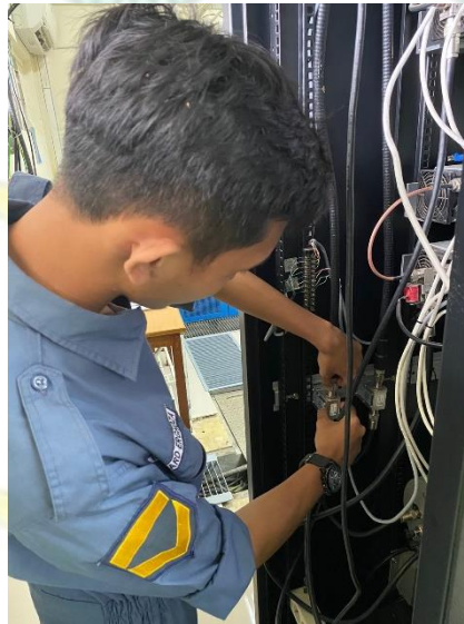
Gambar 3. 26 Melakukan pemasangan antenna surge protector Sumber: Dokumentasi penulis (2023)
