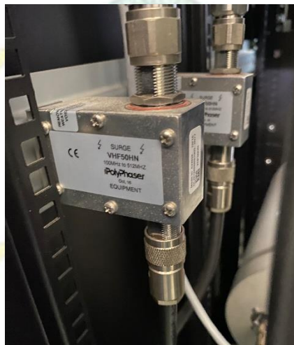
Gambar 3. 23 Antenna Surge Protector Sumber: Dokumentasi Penulis (2023)
