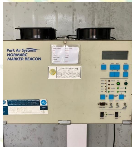
Gambar 3. 13 Peralatan Middle Marker Sumber: Dokumentasi Penulis (2023)
