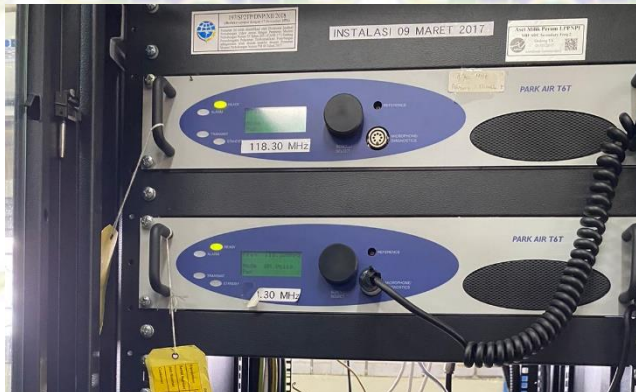
Gambar 3. 6 Peralatan VHF A/G Secondary Transmitter Sumber: Dokumentasi penulis (2023)
