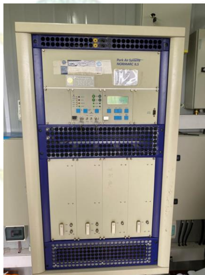
Gambar 3. 15 Peralatan Glide Path Sumber: Dokumentasi Penulis (2023)
