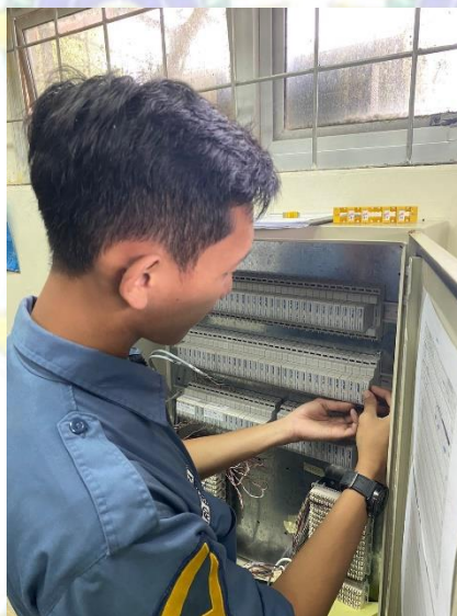
Gambar 3. 25 Melakukan pemasangan arrester pada mdf Sumber: Dokumentasi penulis (2023)
