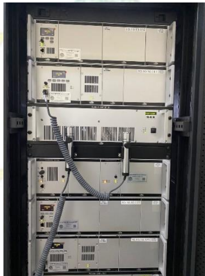
Gambar 3. 11 Peralatan VHF ER Upper Natuna Sumber: Dokumentasi Penulis (2023)
