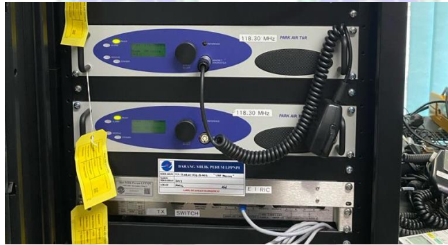
Gambar 3. 7 Peralatan VHF A/G Secondary Receiver Sumber: Dokumentasi penulis (2023)
