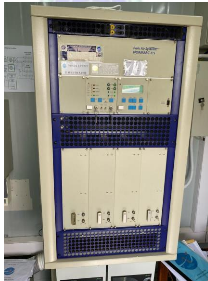
Gambar 3. 14 Peralatan Localizer Sumber: Dokumentasi Penulis (2023)
