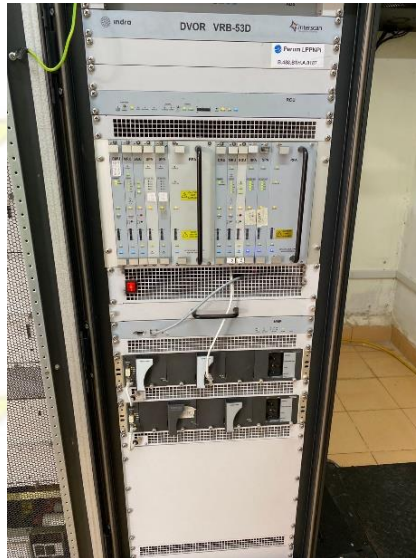
Gambar 3. 16 Peralatan DVOR Sumber: Dokumentasi Penulis (2023)
