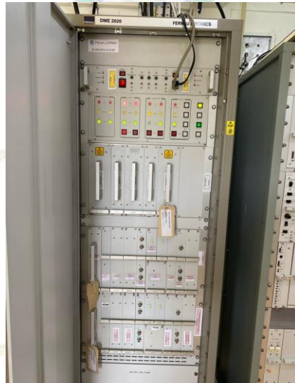
Gambar 3. 18 Peralatan DME Sumber: Dokumentasi Penulis (2023)
