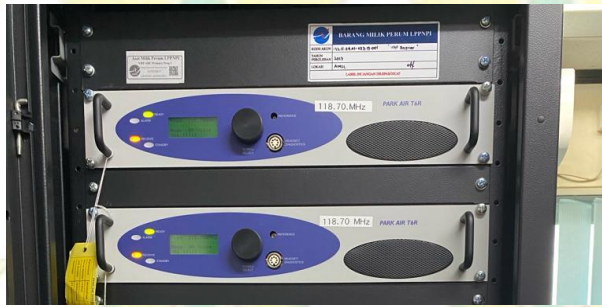
Gambar 3. 5 Peralatan VHF A/G Primary Receiver Sumber: Dokumentasi penulis (2023)
