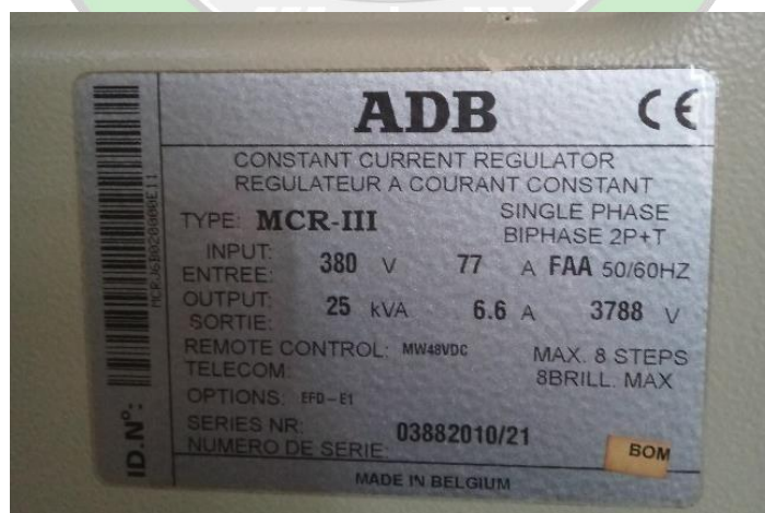
Gambar 2. 32 CCR Runway Edge Light rangkaian II
