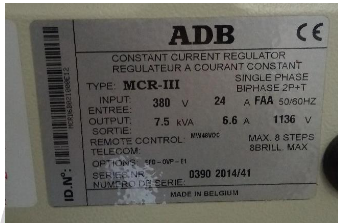
Gambar 2. 35 CCR Taxiway Edge Light Rangkaian A dan B
