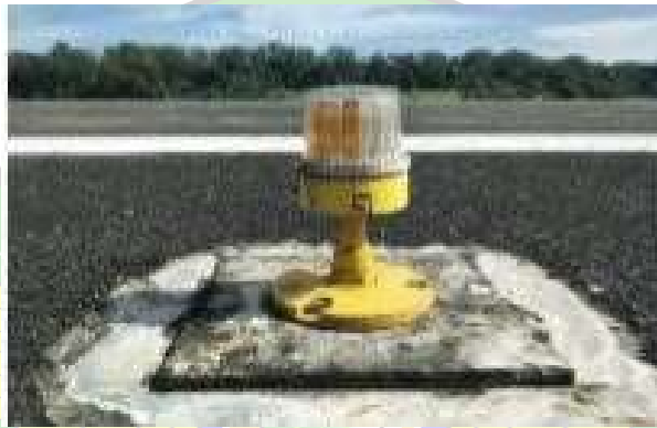
Gambar 4. 9 Runway Edge Light Elevated Sumber : Hasil Karya Penulis
