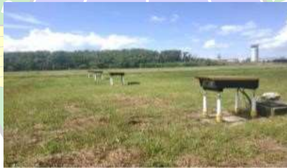
Gambar 4. 8 Precision Approach Path Indicator Sumber : Hasil Karya Penulis
