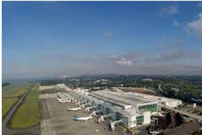
Gambar 2. 4 Terminal Baru Sumber : Internet
