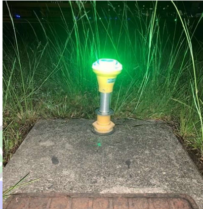
Gambar 4. 14 Heliport Perimeter Light Sumber : Hasil Karya Penulis
