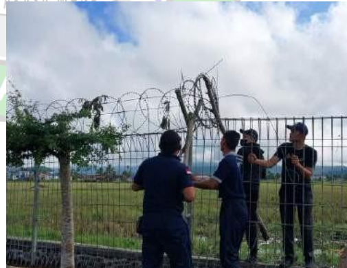
Gotong royong perbaikan pagar perimeter sisi darat
