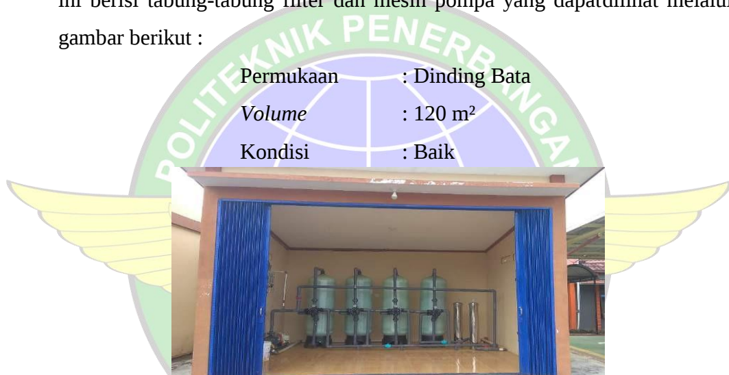
Gambar 4. 13 Gedung WTP Bandara Depati Parbo
