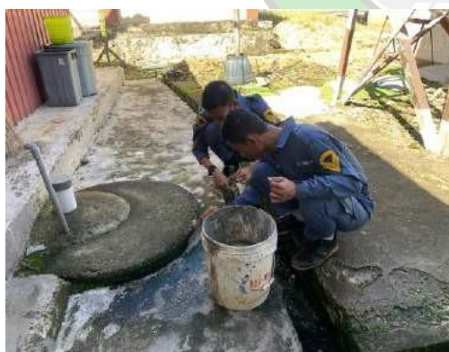
Pengecoran tutup septic tank
