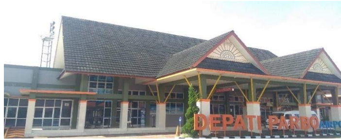
Gambar 4. 7 Terminal Bandara Depati Parbo
