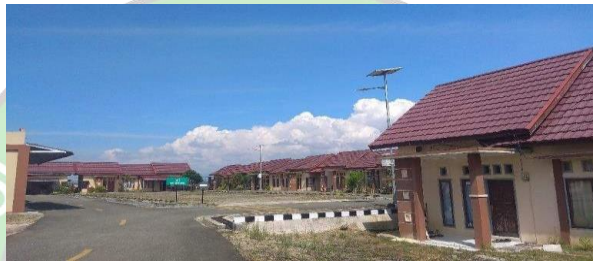
Gambar 4. 11 Komplek Perumahan Dinas Bandara Depati Parbo
