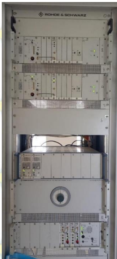
Gambar 3. 2 Kabinet VHF A/G Secondary ADC Sumber : Dokumentasi Penulis (2023)
