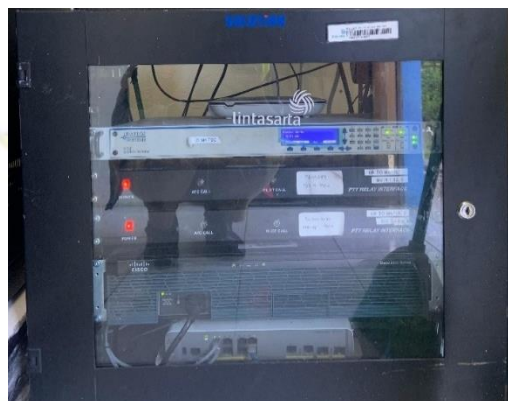
Gambar 3. 19 Perangkat VSAT di Shelter VHF-ER Sumber : Dokumentasi Penulis (2023)
