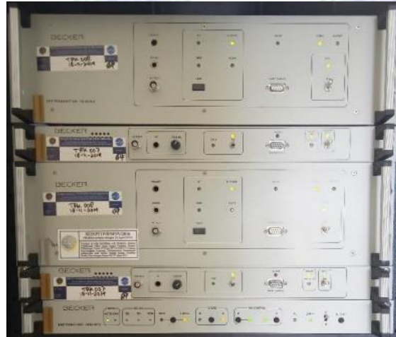
Gambar 3. 1 Kabinet VHF A/G Primary ADC Sumber : Dokumentasi Penulis (2023)
