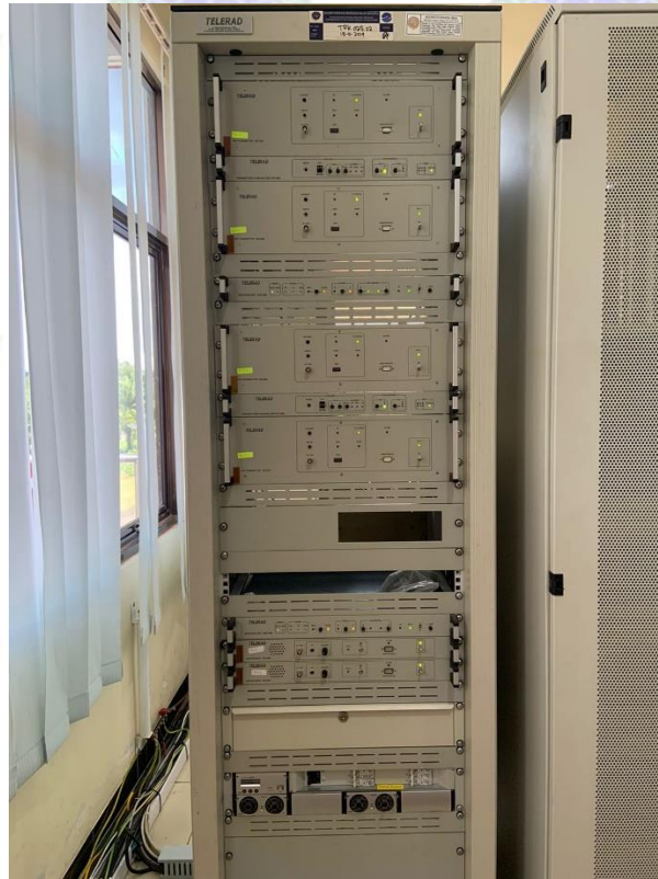
Gambar 3. 4 Kabinet VHF A/G Secondary APP Sumber : Dokumentasi Penulis (2023)
