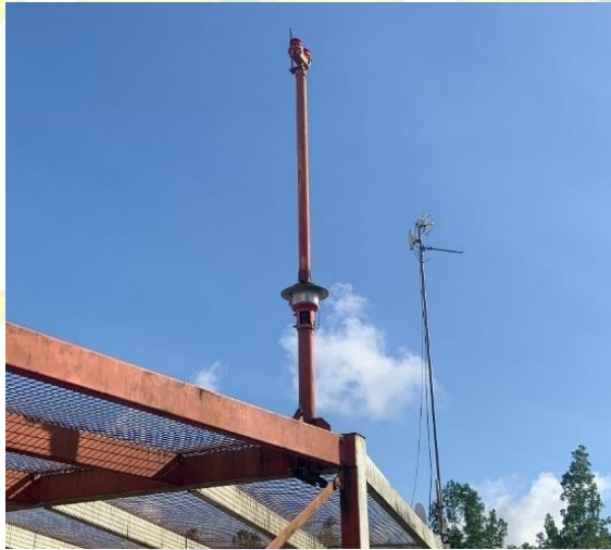
Gambar 3. 29 Antenna DME LDB Collocated Antenna DVOR Sumber : Dokumentasi Penulis (2023)
