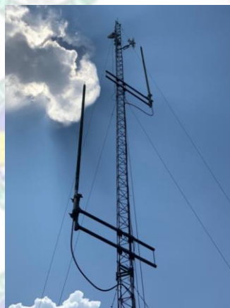
Gambar 3. 24 Antenna VHF ER MATSC Secondary Sumber : Dokumentasi Penulis (2023)
