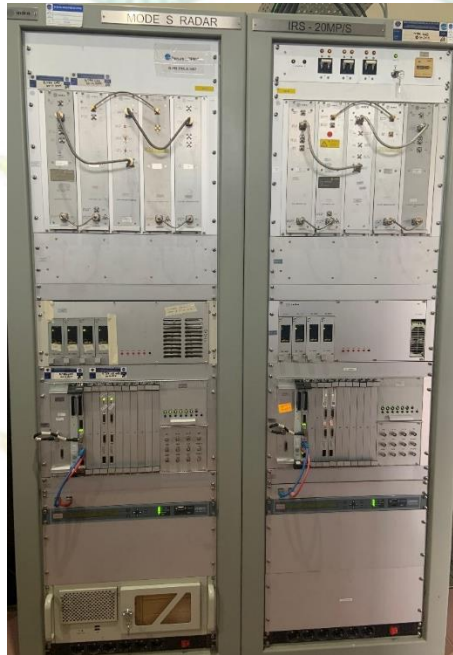
Gambar 3. 49 Kabinet Radar Indra MSSR IRS-20MP/S Sumber : Dokumentasi Penulis (2023)
