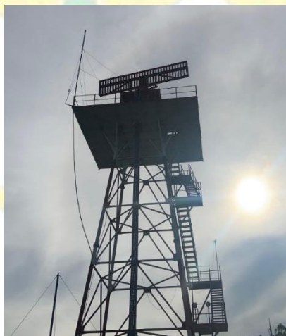
Gambar 3. 50 Antenna dan Gedung Radar MSSR Sumber : Dokumentasi Penulis (2023)
