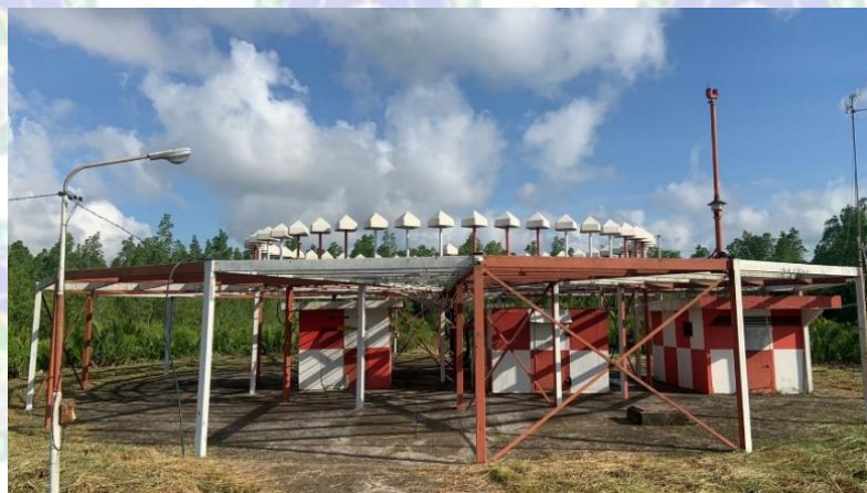
Gambar 3. 25 Antenna dan Shelter DVOR Sumber : Dokumentasi Penulis (2023)
