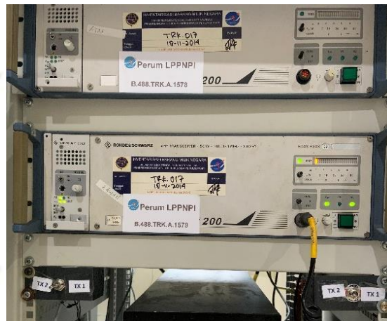
Gambar 3. 58 VHF A/G APP TRX dengan system change over unit Sumber : Dokumentasi Penulis (2023)
