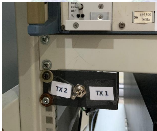
Gambar 3. 60 System change over unit antenna di kiri Sumber : Dokumentasi Penulis (2023)
