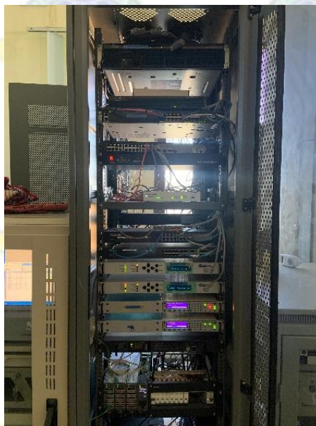
Gambar 3. 20 VSAT di Lantai 3 Perum LPPNPI Tarakan Sumber : Dokumentasi Penulis (2023)
