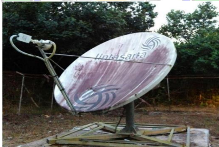
Gambar 3. 18 Antena VSAT Sumber: Dokumentasi Penulis, 2023
