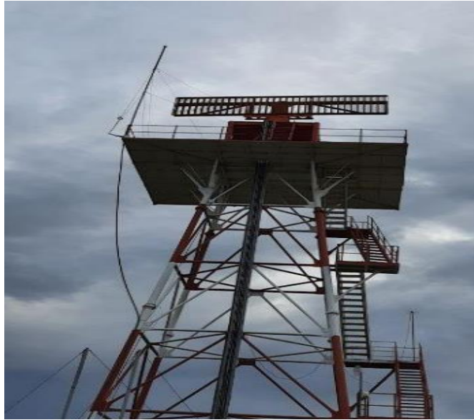
Gambar 3. 31 Antena Radar MSSR Sumber: Dokumentasi Penulis, 2023
