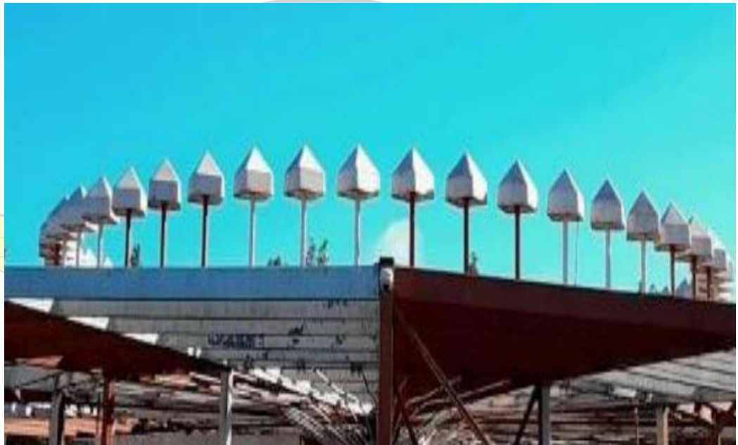
Gambar 3. 27 Antena DVOR Sumber: Dokumentasi Penulis, 2023
