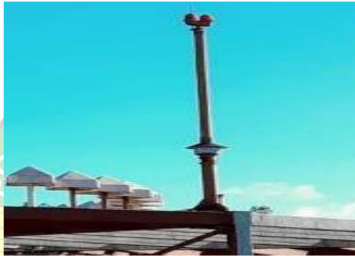
Gambar 3. 29 Antena DME Sumber: Dokumentasi Penulis, 2023
