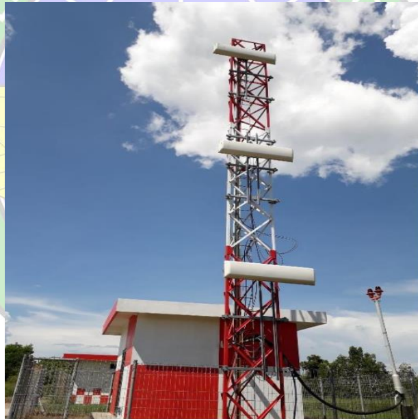
Gambar 3. 23 Antena Glide Path Sumber: Dokumentasi Penulis, 2023
