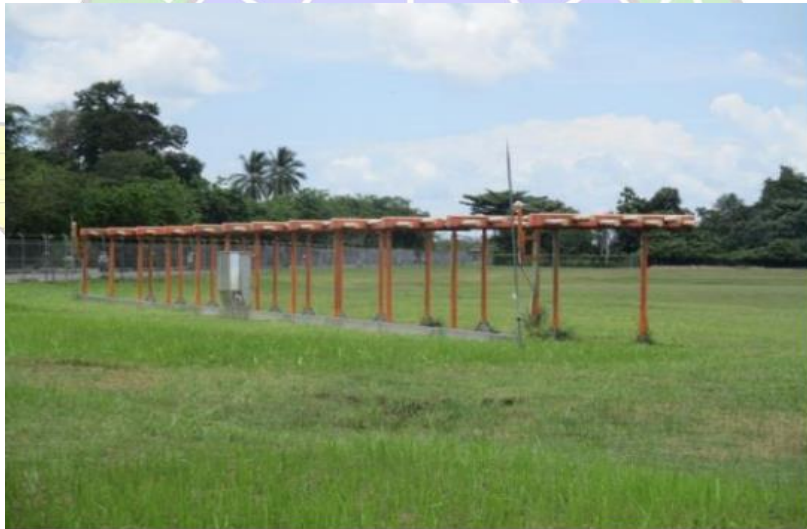
Gambar 3. 20 Antena Localizer Sumber: Dokumentasi Penulis, 2023
