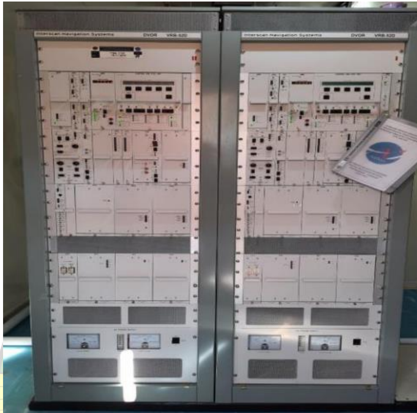
Gambar 3. 28 DVOR INTERSCAN Sumber: Dokumentasi Penulis, 2023
