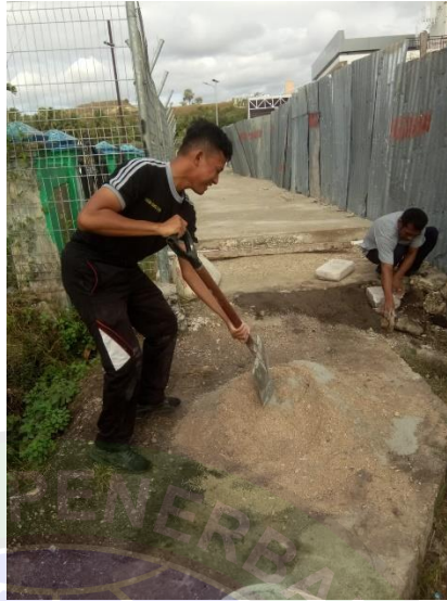
Gambar 4. 21 Proses pencampuran campuran beton
