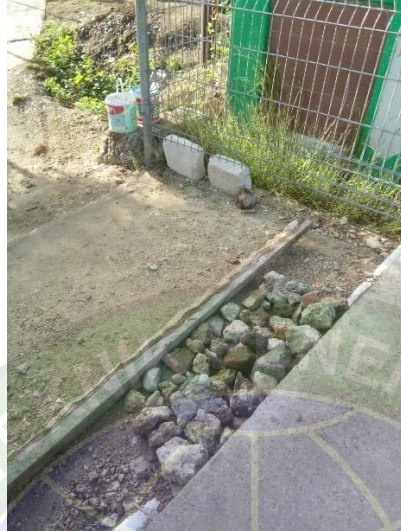
Gambar 4. 19 Perataan tanah untuk ramp 1
