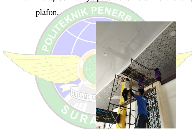
Gambar 4.4 Perbaikan Plafon
