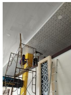
Gambar 4.5 Finishing dan Pengecekan Ulang Plafon
