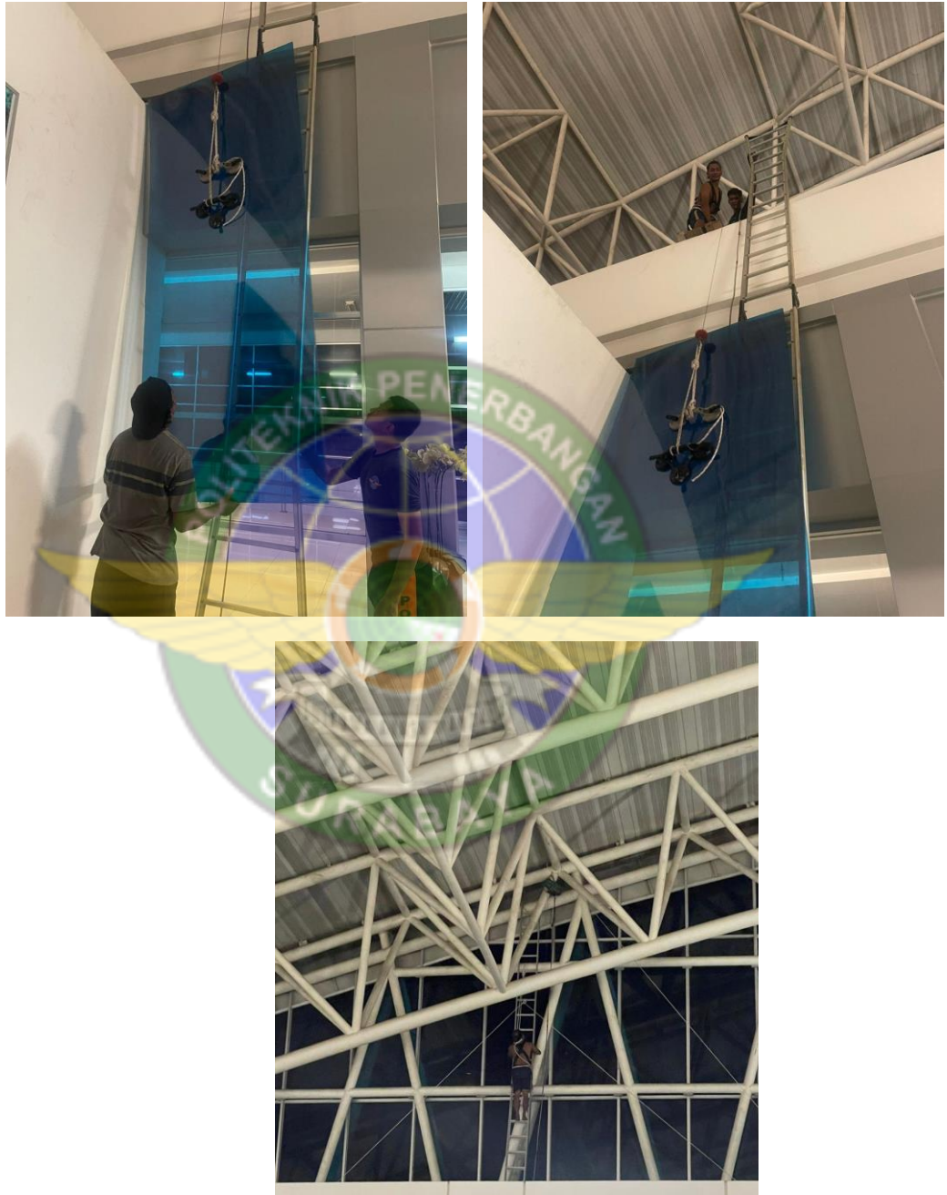
Gambar 4. 42 Proses Pemasangan Solartuff
