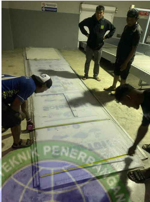
Gambar 4. 39 Pemotongan Solartuff
