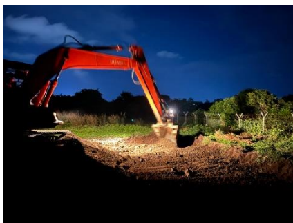
Gambar 4. 16 Proses Pembongkaran Material Sub-base dan Base Course
