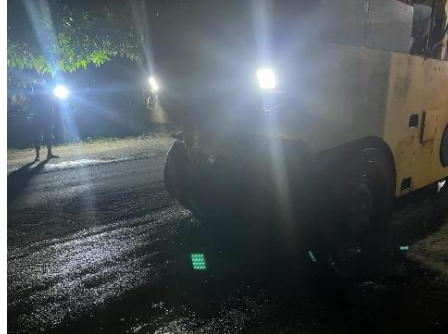
Gambar 4. 32 Proses Pemadatan Antara
