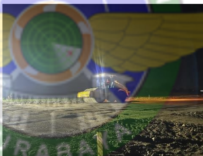
Gambar 4. 17 Proses Penyiapan Subgrade
