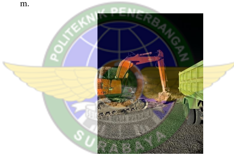
Gambar 4. 15 Proses Pembongkaran Lapis Permukaan Perkerasan Eksisting
