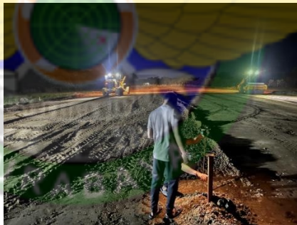
Gambar 4. 23 Proses Pemerataan Material dan Pemadatan Base Course
