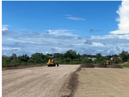
Gambar 4. 20 Proses Pemerataan dan Pemasatan Sub-base Course
