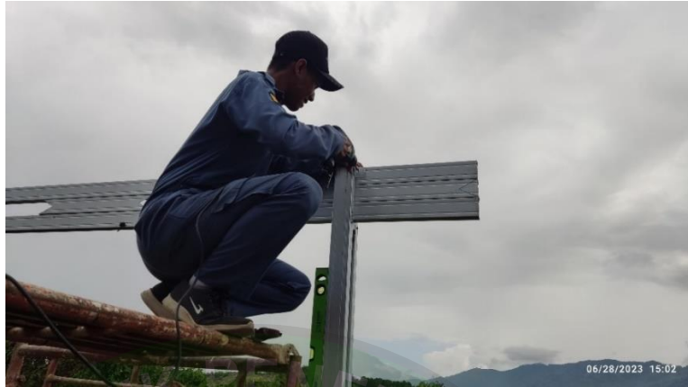
Gambar 4. 49 Pemasangan Penyangga Atap
