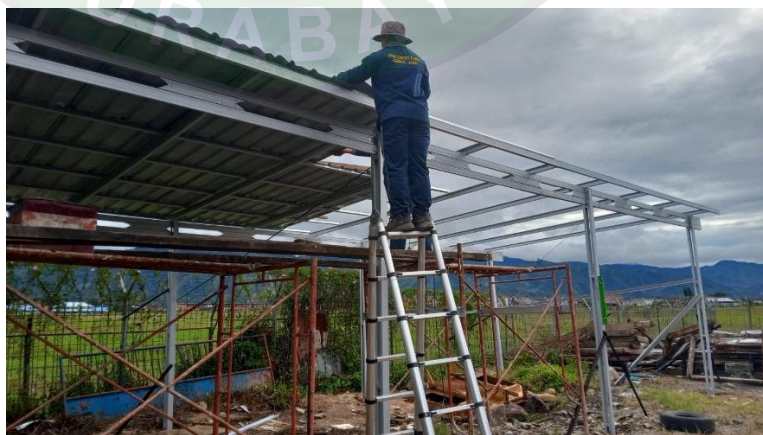
Gambar 4. 51 Pemasangan Atap Spandex
