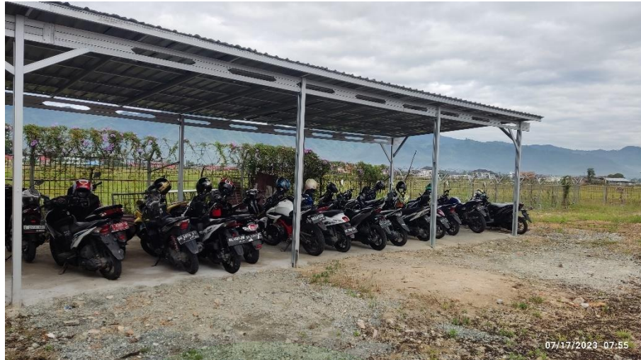
Gambar 4. 9 Parkir Motor Baru Bandar Udara Depati Parbo Kerinci
