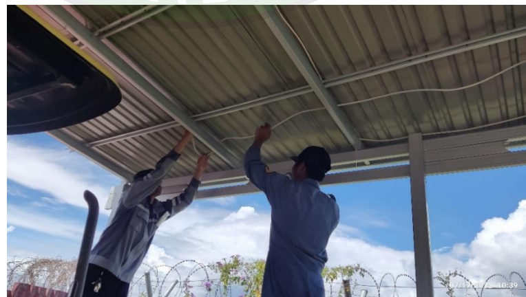
Gambar 4. 54 Instalasi Kabel Lampu
