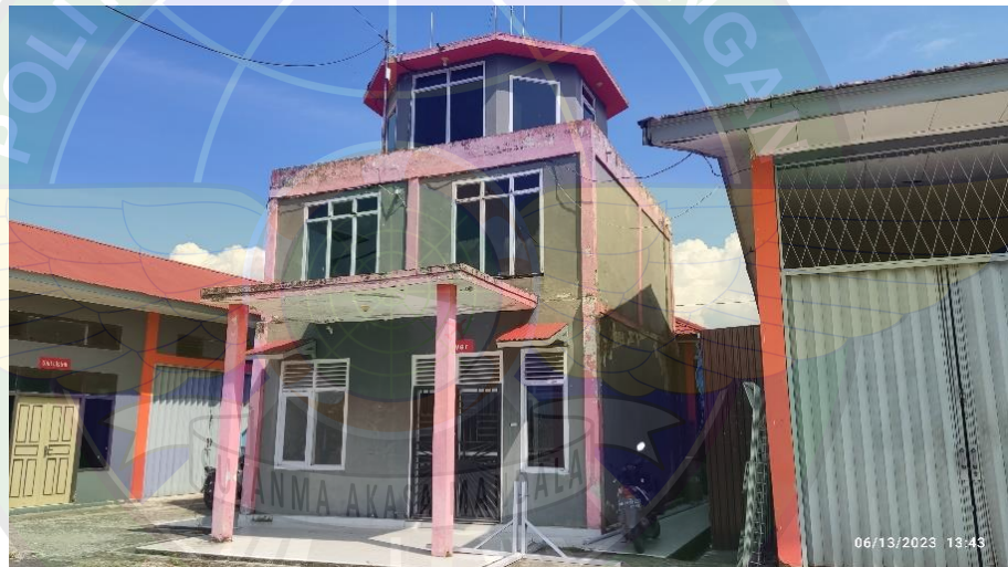
Gambar 4. 2 Tower Bandar Udara Depati Parbo Kerinci
