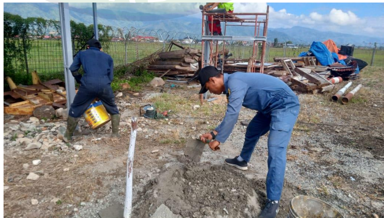
Gambar 4. 48 Pengecoran Pondasi Tiang
