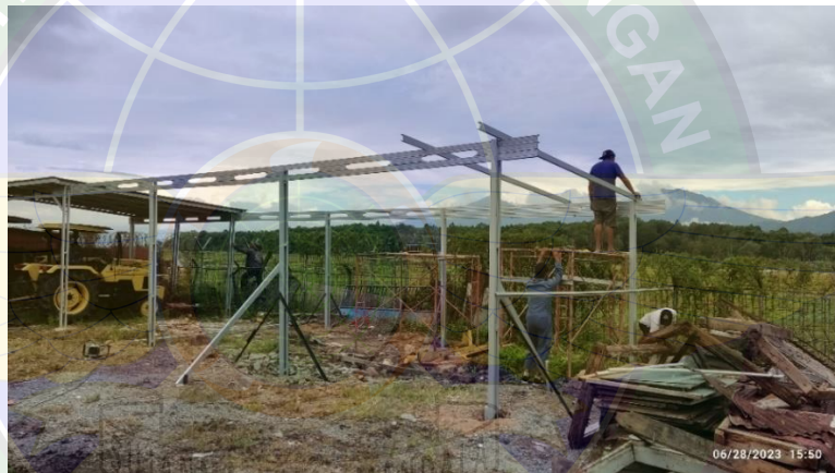
Gambar 4. 50 Pemasangan Rangka Atap Reng
