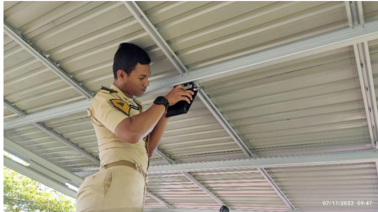
Gambar 4. 55 Pemasangan Lampu
