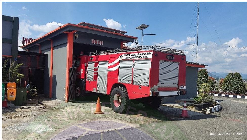
Gambar 4. 5 Gedung PKP - PK Bandar Udara Depati Parbo Kerinci
