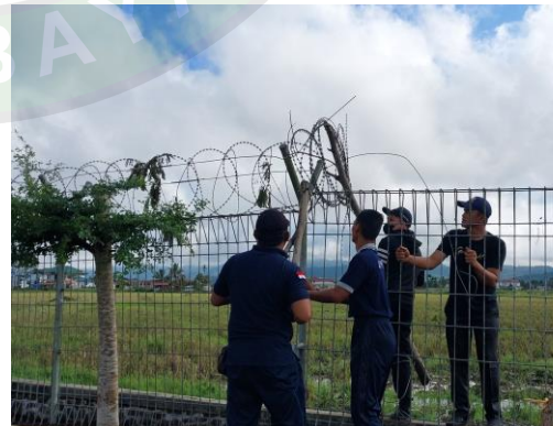
Gotong royong perbaikan pagar perimeter sisi darat
