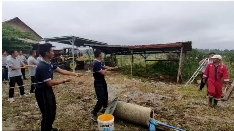
Gambar 4. 43 Pembongkaran Gudang Lama
