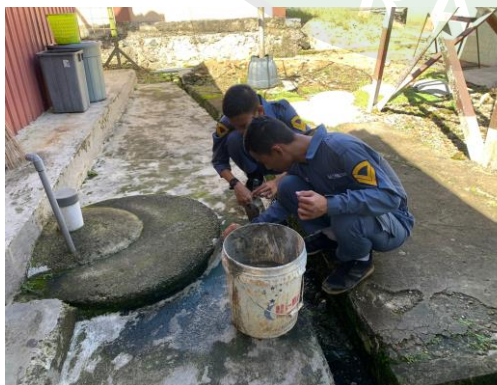
Pengecoran tutup septic tank
