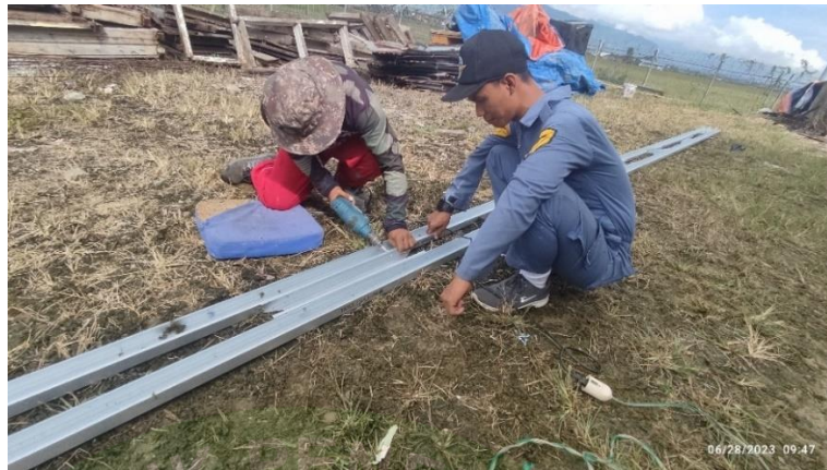
Gambar 4. 46 Pembautan Baja Ringan
