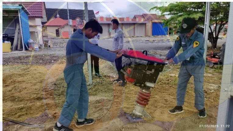
Gambar 4. 53 Pemadatan Tanah Menggunakan Stamper
