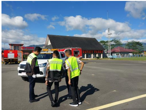
Meninjau kerusakan apron akibat helikopter
