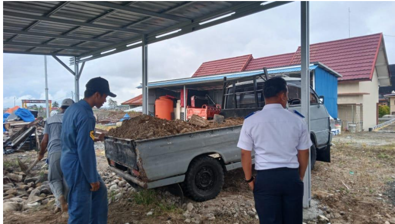
Gambar 4. 52 Penimbunan Pasir Pada Tanah
