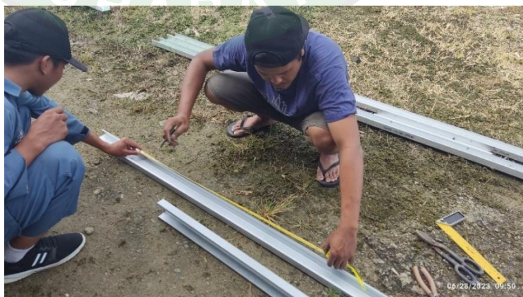
Gambar 4. 45 Pengukuran Baja Ringan Taso dan Reng
