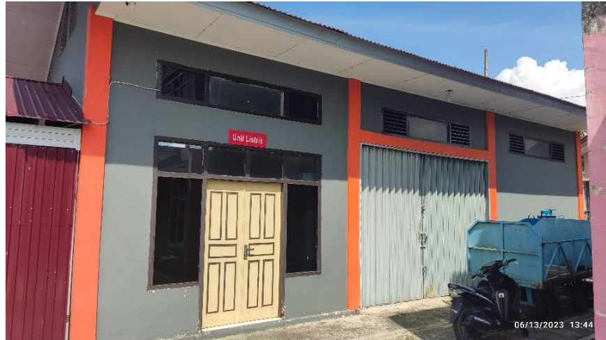
Gambar 4. 3 Power House Bandar Udara Depati Parbo Kerinci
