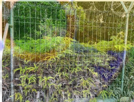
Gambar 4. 18 Pagar yang sudah dibaut
