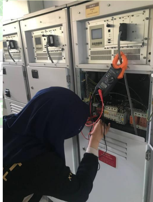
Pengukuran arus pada CCR
