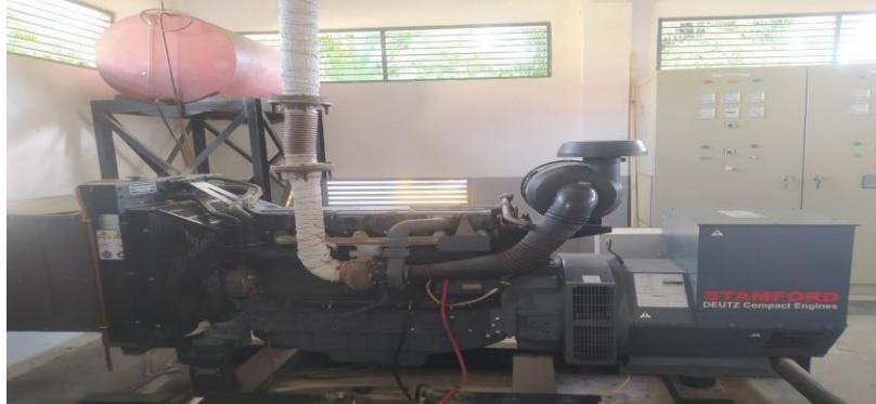
Gambar 4. 2 Genset 140kVA Sumber : Bandar Udara Tampa Padang
