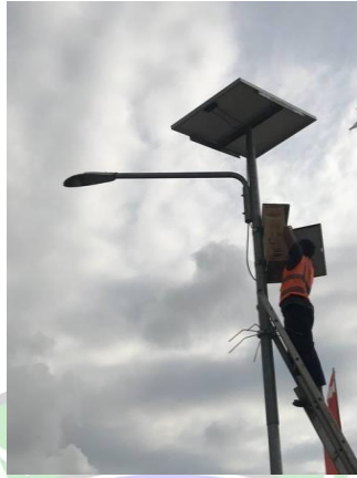
Gambar 4. 10 Penggantian Baterai saat Perbaikan Sumber: Data Pribadi Penulis
