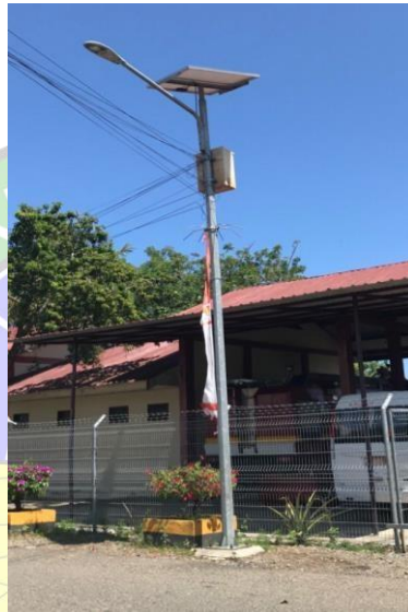
Gambar 3. 1 PJU Solar Cell Sumber : Data Pribadi Penulis
