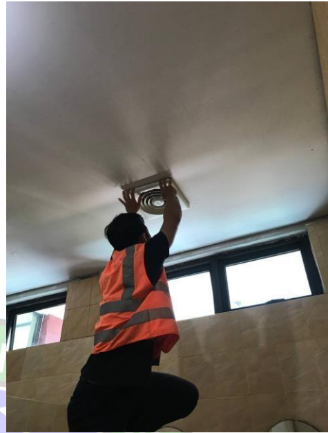
Perbaikan lampu pada toilet terminal bandara
