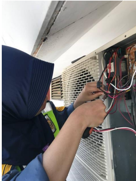
Penggantian kontaktor pada outdoor AC terminal
