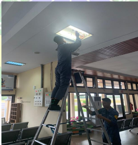
Pemasangan Lampu TL di terminal
