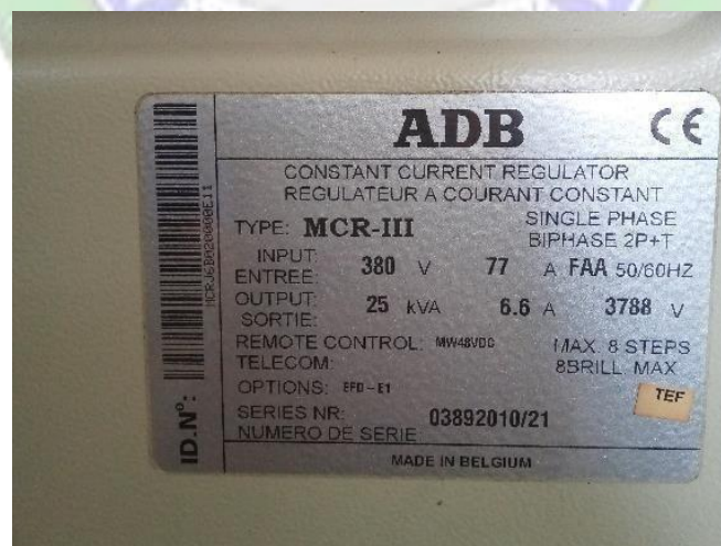
Gambar 2.31CCR Runway Edge Light rangkaian I
