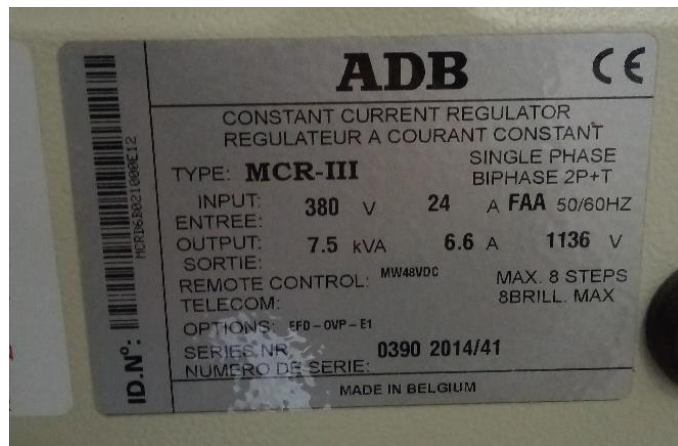
Gambar 2.35CCR Taxiway Edge Light Rangkaian A dan B
