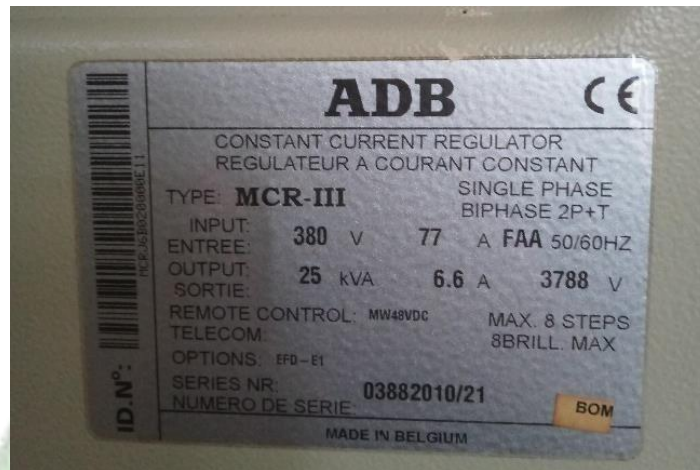
Gambar 2.32 CCR Runway Edge Light rangkaian II
