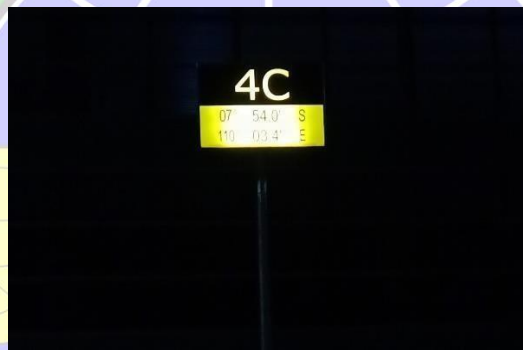
Gambar 2. 17 Spot Number Light Sumber: Bandar Udara Internasional Yogyakarta
