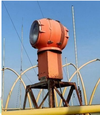
Gambar 2. 19 Rotating Beacon Sumber: Bandar Udara Internasional Yogyakarta
