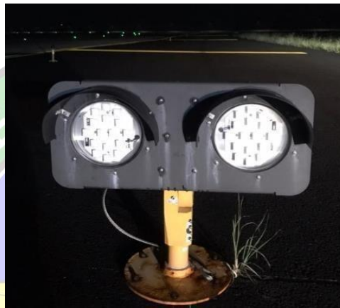
Gambar 2. 9 Runway Guard Light Sumber: Bandar Udara Internasional Yogyakarta
