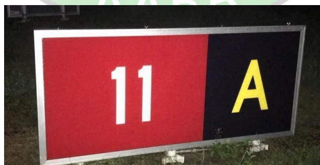
Gambar 2. 15 Movement Area Guidance Sign Sumber: Bandar Udara Internasional Yogyakarta
