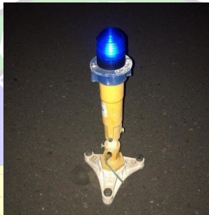
Gambar 2. 10 Taxiway Edge Light Sumber: Bandar Udara Internasional Yogyakarta
