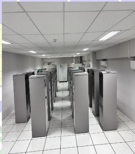
Gambar 2. 21 Ruang CCR Sumber: Bandar Udara Internasional Yogyakarta
