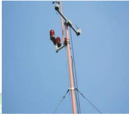
Gambar 2. 23 Obstruction Light Sumber : Bandar Udara El-Tari Kupang Th. 2021
