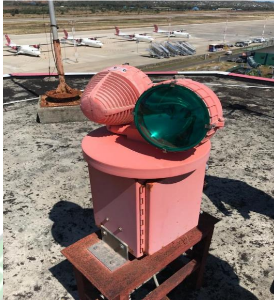
Gambar 2. 19 Rotating Beacon Sumber : Bandar Udara El-Tari Kupang Th. 2021
