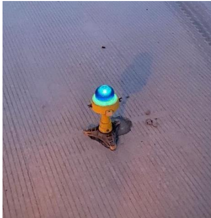
Gambar 2. 16 Taxiway Edge Light Sumber : Bandar Udara El-Tari Kupang Th. 2021
