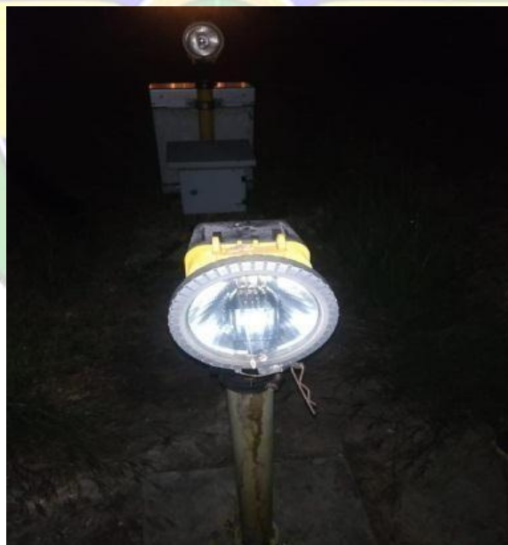
Gambar 2. 12 Approach Light Sumber : Bandar Udara El-Tari Kupang Th. 2021
