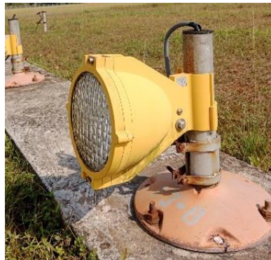
Gambar 2.19 Lampu APH Sumber: PT Bandara Internasional Batam
