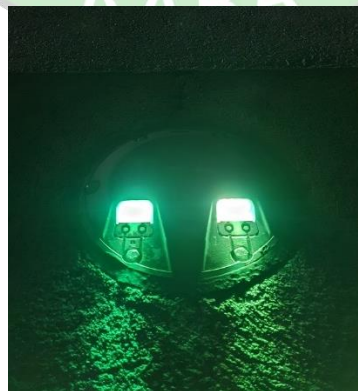
Gambar 3.7 Lampu tipe Inset Sumber : PT.Bandara Internasional Batam
