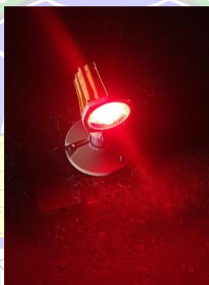
Gambar 2.18 Lampu Runway End Sumber: PT Bandara Internasional Batam
