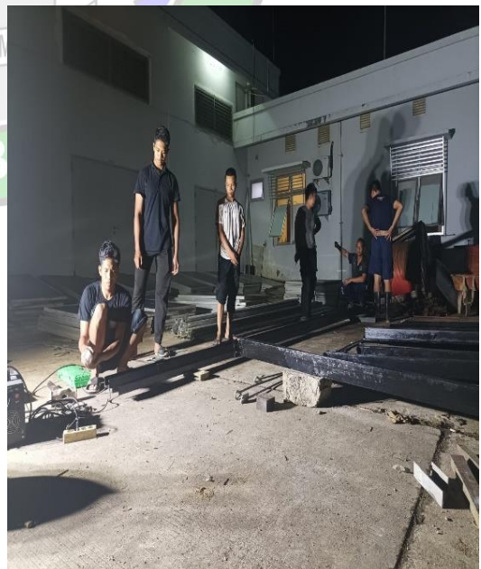
"Pengelasan besi pondasi solar cell"
