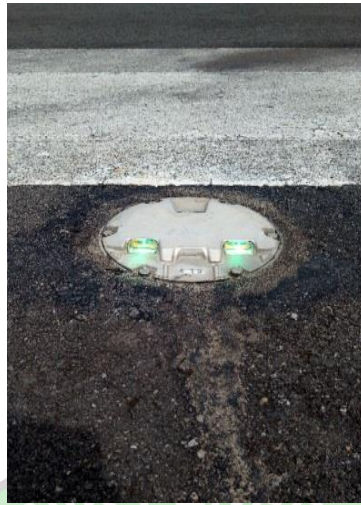
Gambar 2. 24 Insert Threshold Light Sumber : Dokumentasi Penulis
