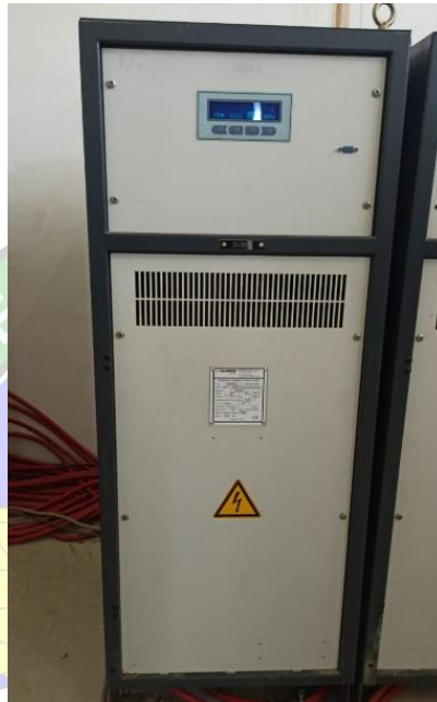
Gambar 2. 20 CCR ( Constant Current Regulator) Sumber : Dokumentasi Penulis
