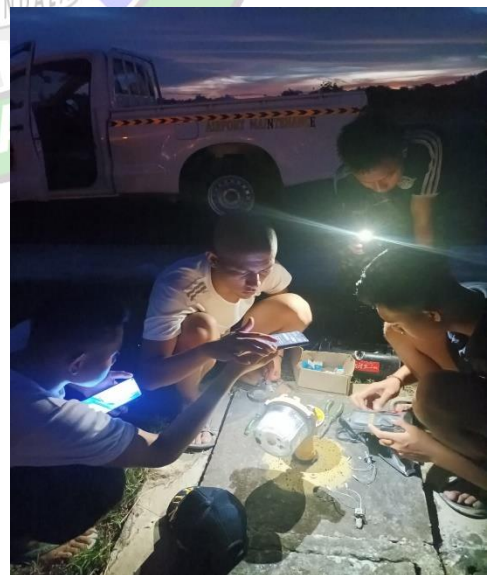
“Penggantian Lampu Runway Edge Light ”
