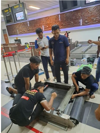
"Perbaikan conveyor"
