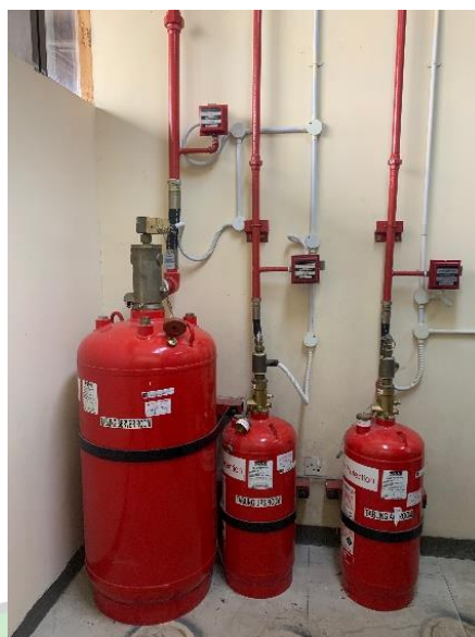
Gambar 3. 14 Fire Suppression System Bandara Hang Nadim Batam Sumber: Dokumentasi Penulis 2024
