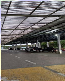
Gambar 4. 12 Penerangan Area Dropzone Penumpang
