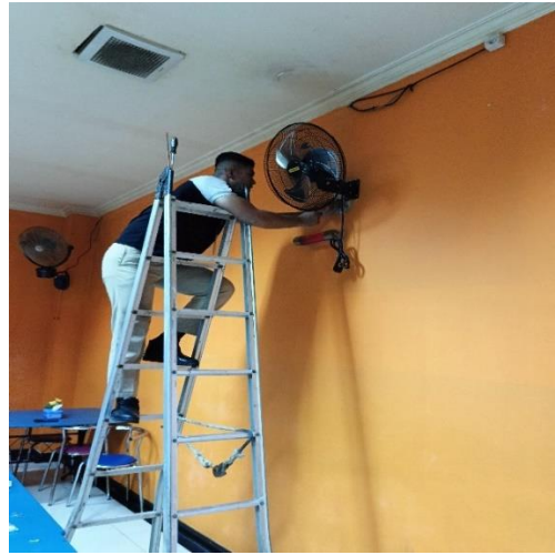
Pemasangan Kipas Angin Di Area Kantin
