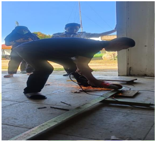
Pembuatan Dudukan Conveyor Timbangan
