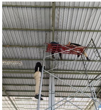
Gambar 4. 15 Pembongkaran Lampu
