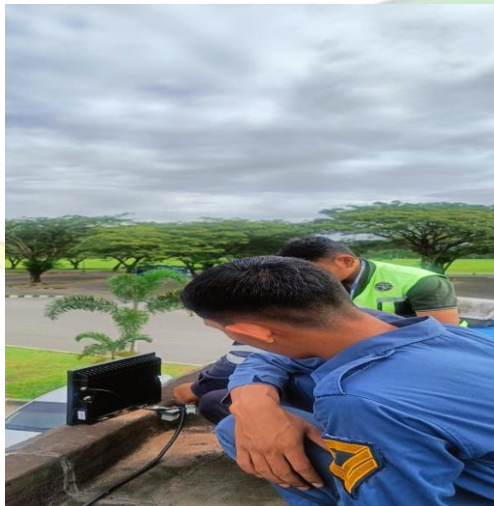
Pemasangan Lampu Sorot area Parkir
