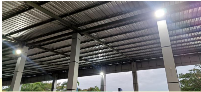
Gambar 3. 1 Penerangan Area Dropzone penumpang
