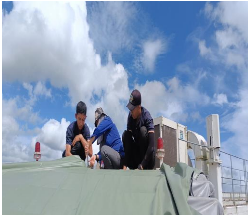
Pemasangan cover garbarata
