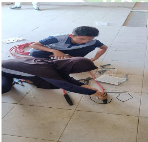
Penuangan Resin ke konektor kabel
