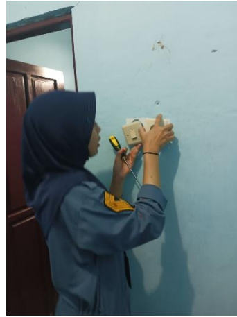
PERBAIKAN STOP KONTAK RUMDIN
