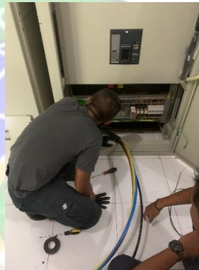
Gambar 4. 32 Pengupasan Kabel
