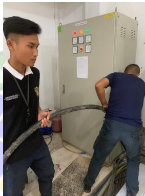
Gambar 4. 27 Memasukkan Kabel ke Parit
