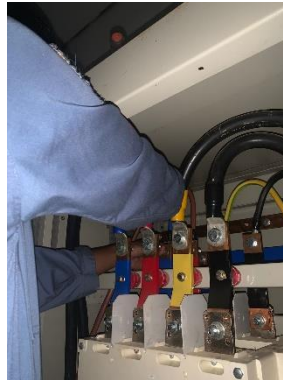
Gambar 4. 34 Penginstalan Kabel ke Panel Distribusi
