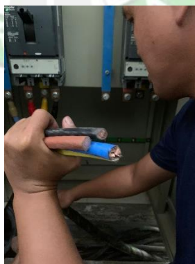
Gambar 4. 28 Pengupasan Kabel
