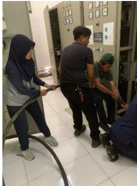
Gambar 4. 26 Memasukkan Kabel ke Parit
