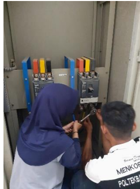
Gambar 4. 31 Penginstalan Kabel Panel ACOS 250 kVA
