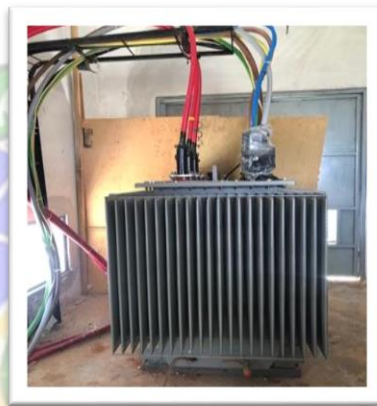
Gambar 4. 4 Trafo Step-Down
