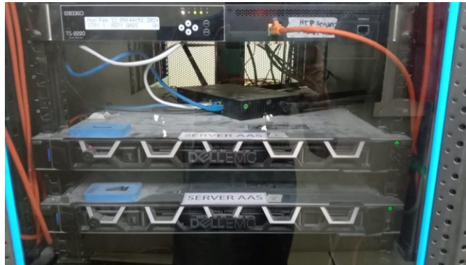
Gambar 3. 8 Server Automatic Announcement System (AAS) Sumber : Dokumentasi Penulis 16 Januari 2024
