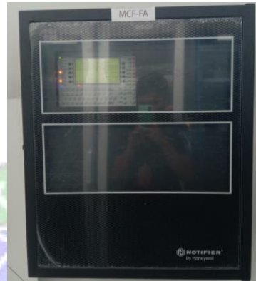
Gambar 3. 5 Main Control Fire Alarm (MCFA) Sumber : Dokumentasi Penulis 16 Januari 2024
