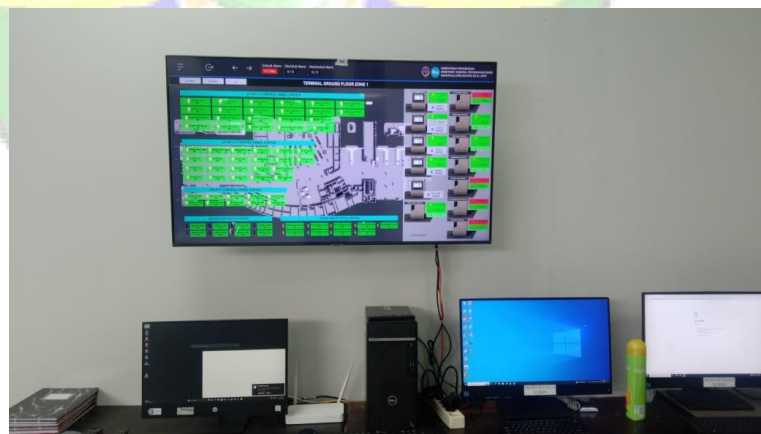
Gambar 3. 7 Monitor Building Automation System (BAS) Sumber : Dokumentasi Penulis 16 Januari 2024
