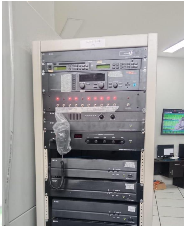
Gambar 3. 6 Kabinet Server Public Address System (PAS) Sumber : Dokumentasi Penulis 16 Januari 2024
