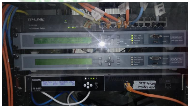
Gambar 3. 9 Server Master Clock Sumber : Dokumentasi Penulis 16 Januari 2024
