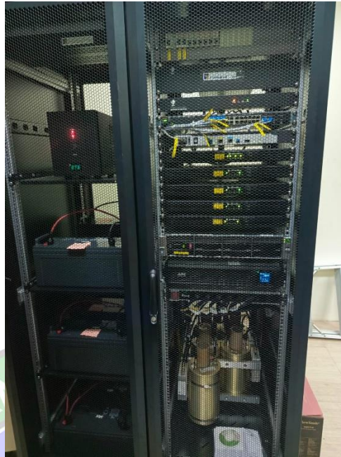
Gambar 3. 13 Radio Trunking di PT Bandara Internasional Batam Sumber : Dokumentasi Penulis, 2024
