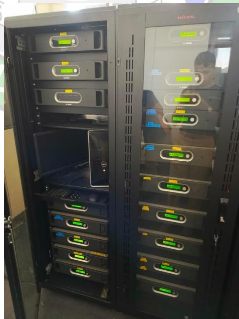
Gambar 3. 9 PAS di PT Bandara Internasional Batam Sumber : Dokumentasi Penulis, 2024
