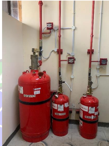
Gambar 3. 7 Tabung FM 200 di PT Bandara Internasional Batam Sumber : Dokumentasi Penulis, 2024
