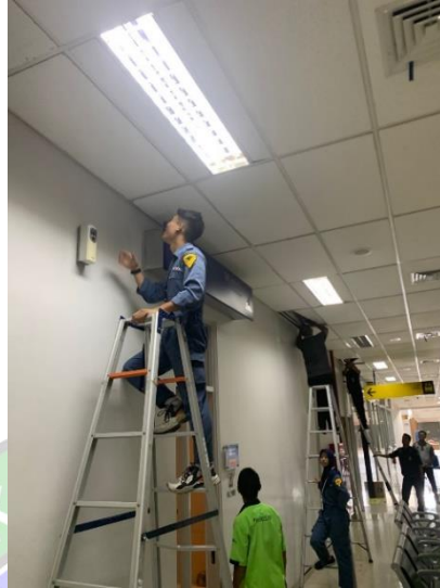
Gambar 3.24 Pembentangan Kabel Sesuai Dengan Jalur
