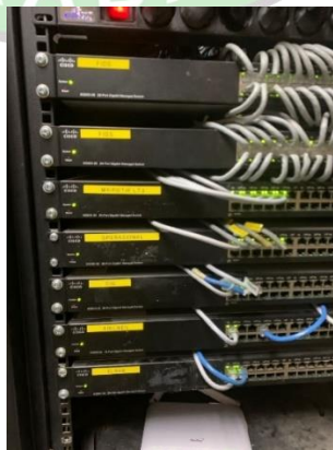
Gambar 3.25 Penghubungan Kabel FO dengan Switch Elband
