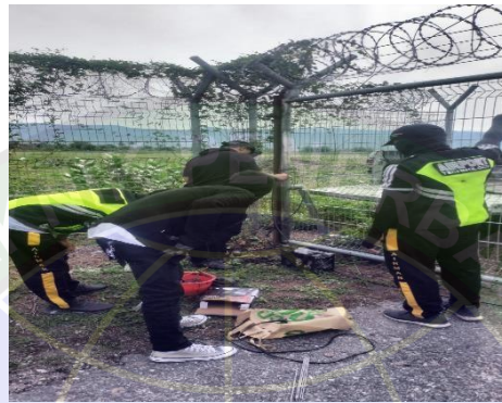
Gambar 4. 15 Pengelasan pagar perimeter
