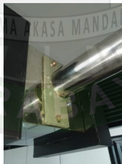
Gambar 4. 13 Pemasangan Baut Drilling (Sumber: Dokumentasi Pribadi, 2024)
