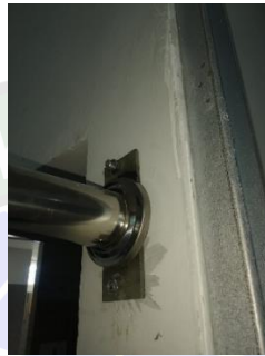
Gambar 4. 12 Pemasangan Dynabolt (Sumber: Dokumentasi Pribadi, 2024)
