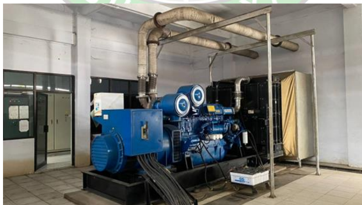
Gambar 4. 2 Genset 1000 KVA Sumber : Bandar Udara Mutiara Sis Al-Jufri
