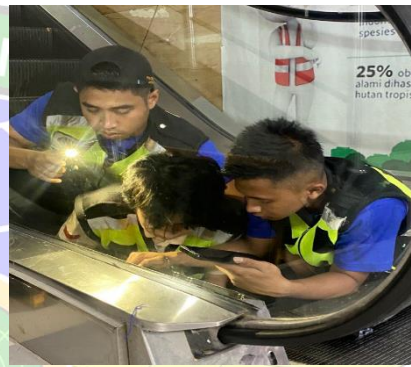
Pergantian komponen eskalator
