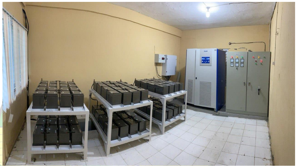
Gambar 4. 7 UPS 160 KVA Sumber: Bandar Udara Mutiara Sis Al-Jufri
