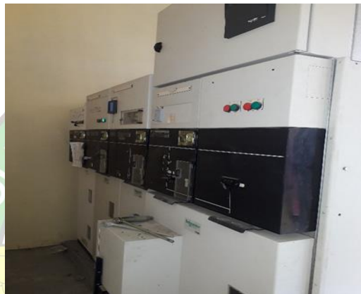
Gambar 4. 5 Kubikel Sumber: Bandar Udara Mutiara Sis Al-Jufri
