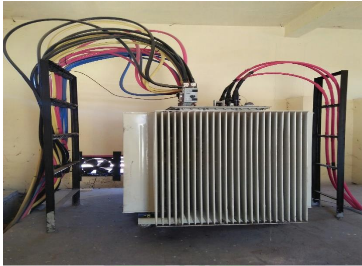
Gambar 4. 6 Transformator Daya Sumber: Bandar Udara Mutiara Sis Al-Jufri
