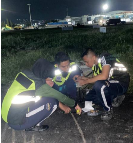
Pemasangan kabel lampu insert
