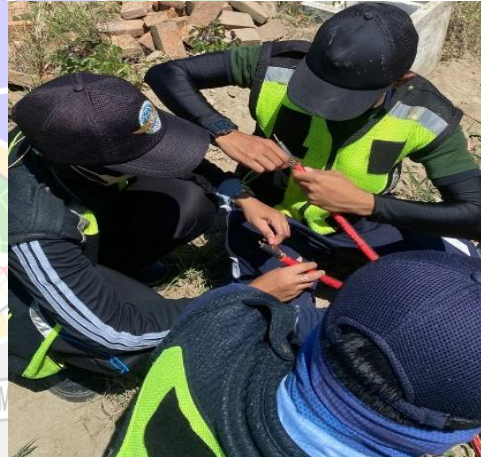
Pemasangan kabel grounding
