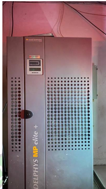
Gambar 4. 8 UPS 120 KVA Sumber: Bandar Udara Mutiara Sis Al-Jufri
