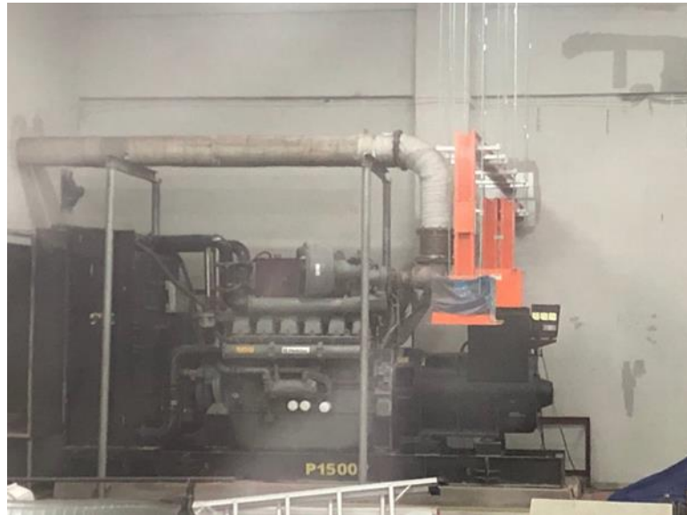
Gambar 4. 3 Genset 1500 KVA Sumber : Bandar Udara Mutiara Sis Al-Jufri
