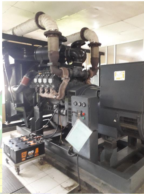
Gambar 4. 1 Genset 500 KVA Sumber : Bandar Udara Mutiara Sis Al-Jufri
