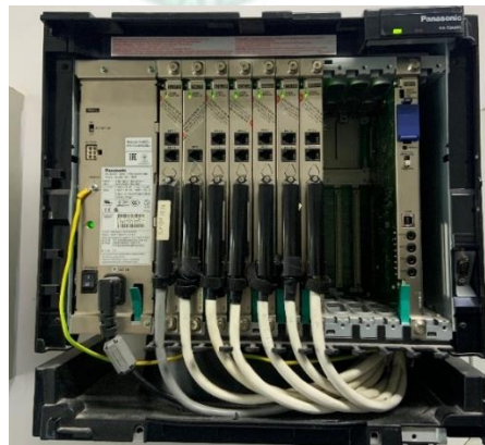
Gambar 3. 17 PABX Hybrid Terminal Bandara Internasional Juwata Sumber : Dokumentasi Penulis (2024)
