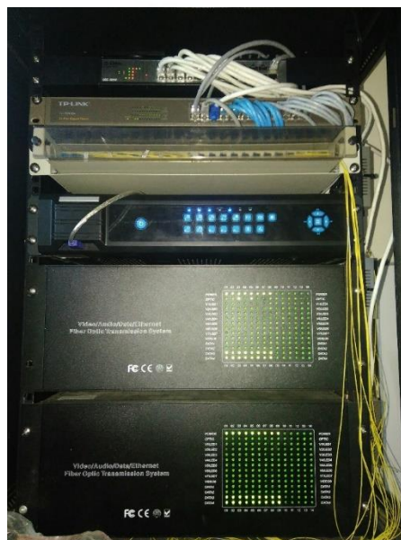
Gambar 3. 32 Network Video Recorder Sumber : Dokumentasi Penulis (2024)
