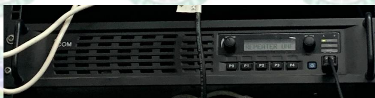
Gambar 3. 2 Repeater UHF Sumber : Dokumentasi Penulis (2024)
