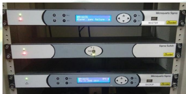
Gambar 3. 23 Server Master Clock Sumber : Dokumentasi Penulis (2024)
