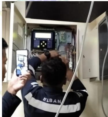
Gambar 3. 51 Pengecekan jalur input dan output Sumber : Dokumentasi Teknisi Elban 2024
