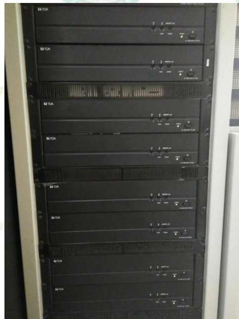
Gambar 3. 12 Amplifier Sumber : Dokumentasi Penulis (2024)
