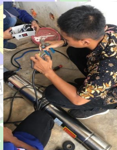
Gambar 4 Pemasangan pompa baru 3phase di Unit PKP-PK
