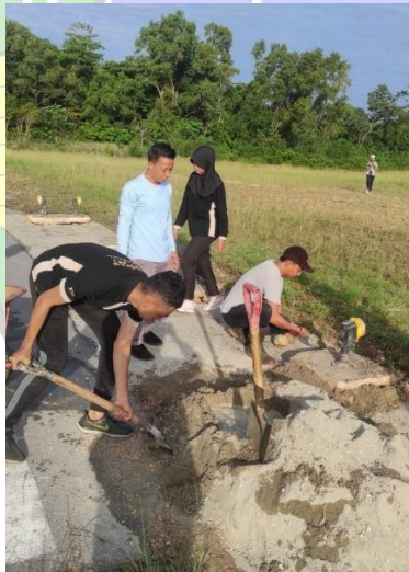
Gambar 7 Proses cor untuk meninggikan dudukan lampu THRESHOLD
