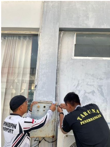
Gambar 5 Pemasangan Photo cell
