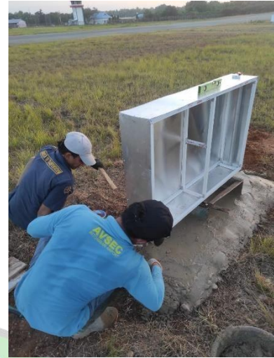
Gambar 10 Pengecoran TGS BRAVO
