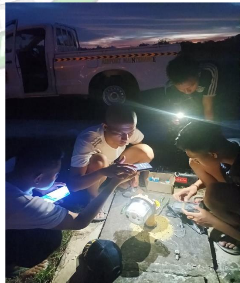
“Penggantian Lampu Runway Edge Light ”
