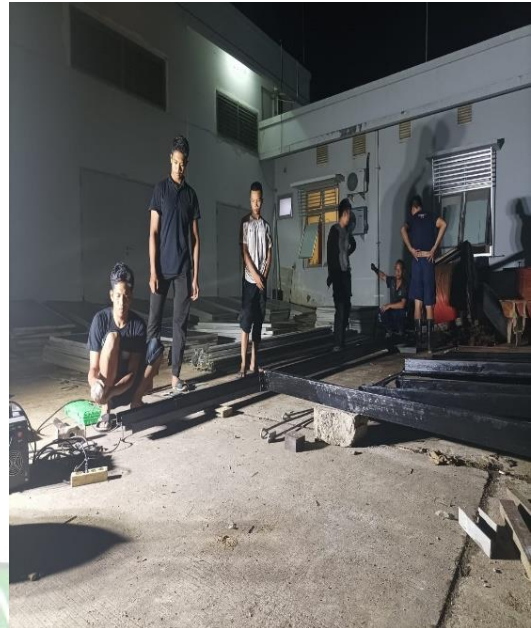
"Pengelasan besi pondasi solar cell"
