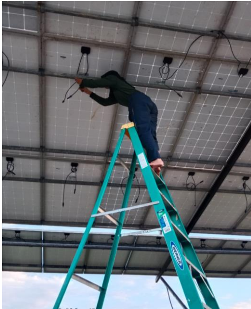
"Penyambungan sambungan solar cell"
