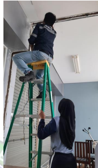
"Pemasangan Instalasi di warung terminal"
