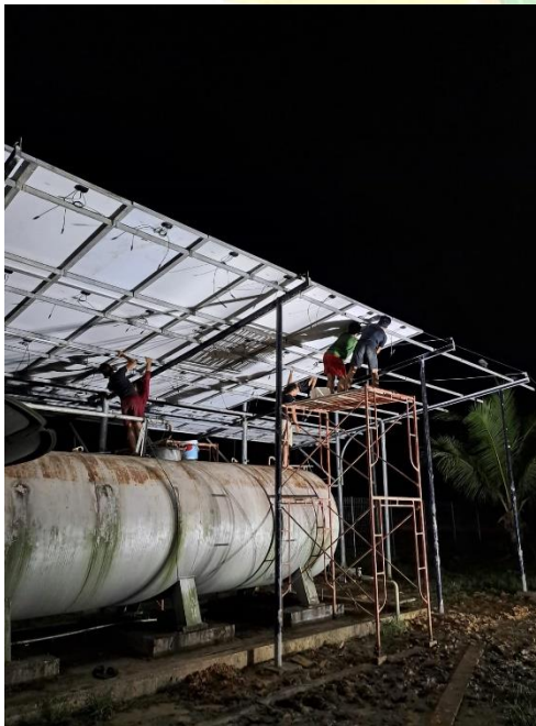
"Perbaikan dan pemasangan solar cell "
