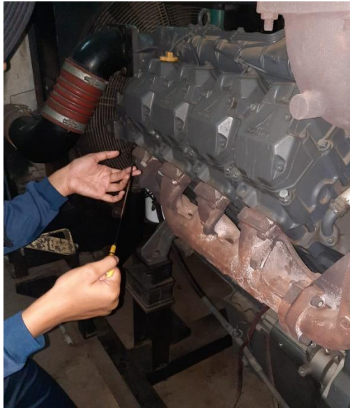
"Pengecekan oli genset"
