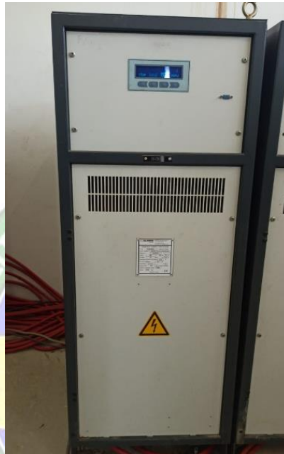
Gambar 2. 20 CCR ( Constant Current Regulator) Sumber : Dokumentasi Penulis
