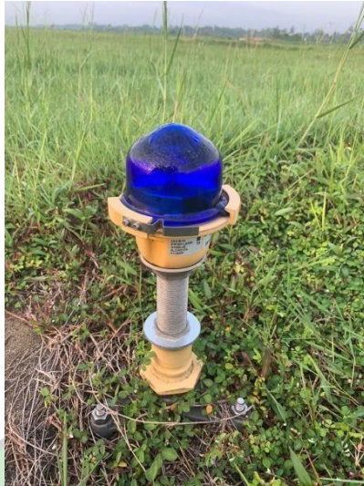
Gambar 2. 7 Lampu Taxiway Sumber: Bandar Udara Internasional Supadio
