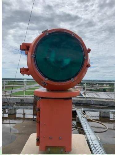
Gambar 2. 10 Rotating Beacon Light Sumber: Bandar Udara Internasional Supadio
