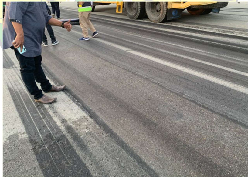
Gambar 4.14 Hasil dari pembersihan yang dilakukan oleh mobil rubber deposit
