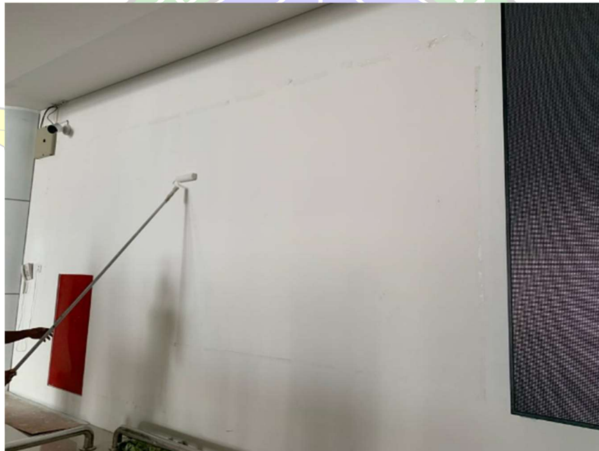
Gambar 4.17 Pengecatan menggunakan kuas roll pada area kedatangan
