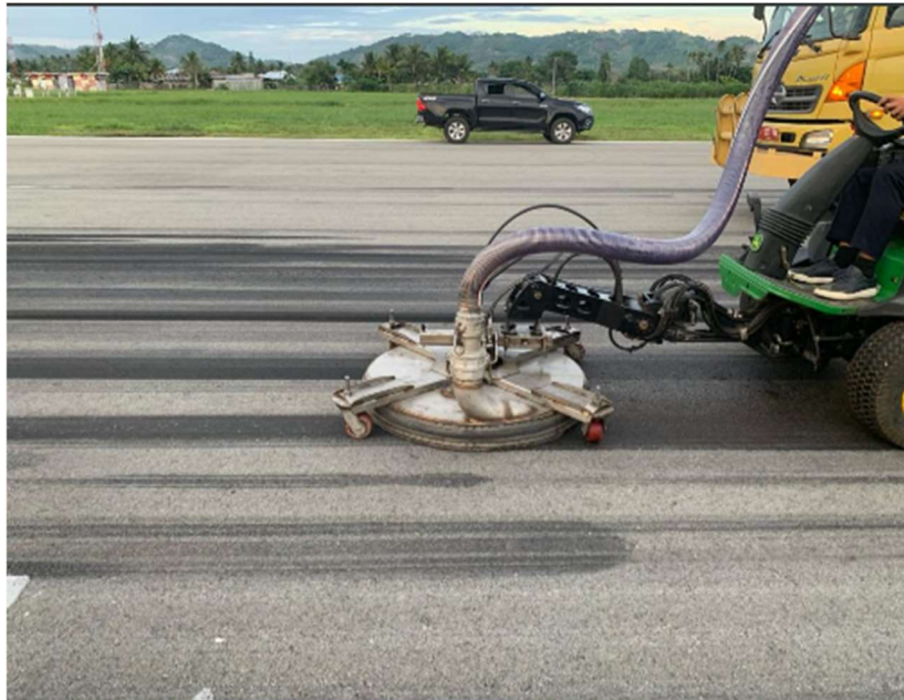
Gambar 4.13 Proses pemberian tekanan air yang tinggi sekaligus penyedotan pada rubber deposit
