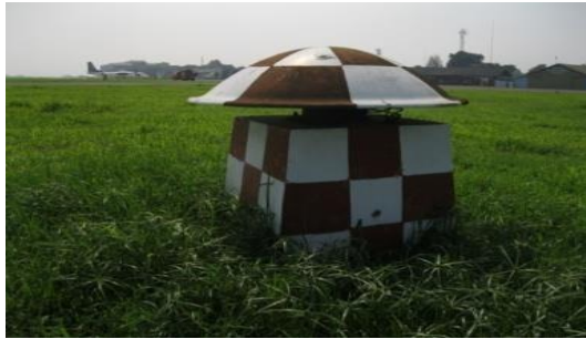
Gambar 2. 20 Sirine (Horn) Sumber : Bandara Husein Sastranegara
