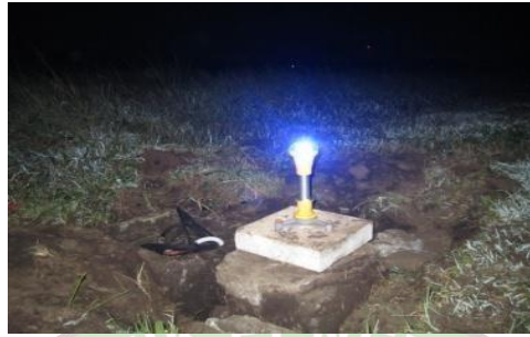
Gambar 2. 13 Turning Area Light Sumber: Bandara Husein Sastranegara
