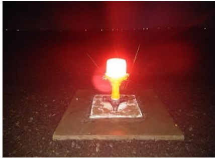
Gambar 2.10 Runway End Light Elevated Sumber : Bandara Husein Sasranegara
