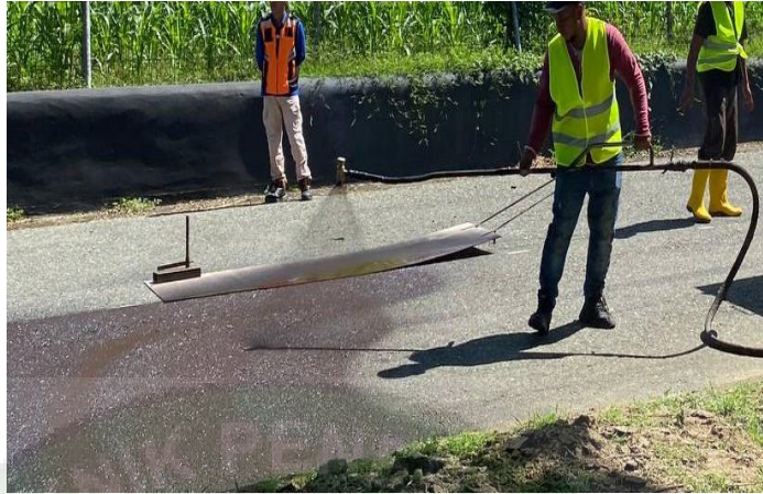
Gambar 4. 41 Penyemprotan Cairan Tack Coat (Sumber : Dokumen Pribadi)
