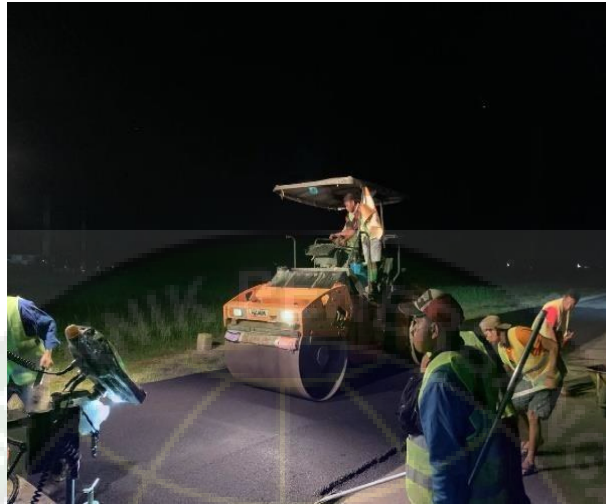
Gambar 4. 44 Pemadatan dengan Tandem Roller (Sumber : Dokumen Penulis)
