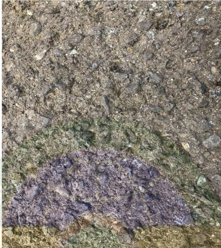
Gambar 4. 13 Kondisi Permukaan Apron Cargo Sebelum Overlay
