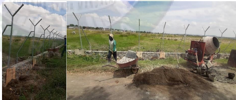
Gambar 4. 13 Pemasangan tiang Y
