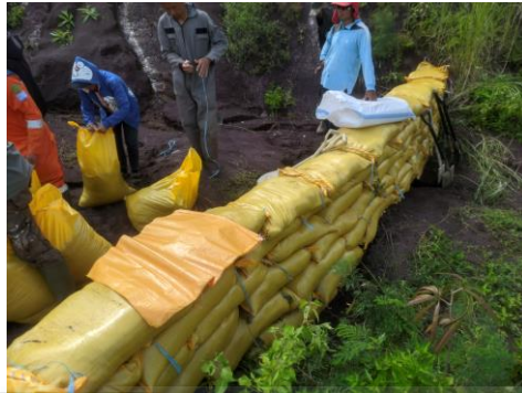
Gambar 4. 28 Penyusunan talut
